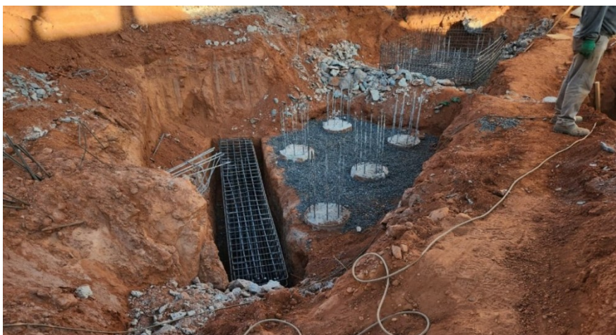
Figura 16: Posicionamento de armadura dos blocos B123 e B136
