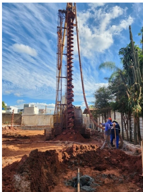
Figura 9: Perfuração por hélice contínua por meio da perfuratriz
