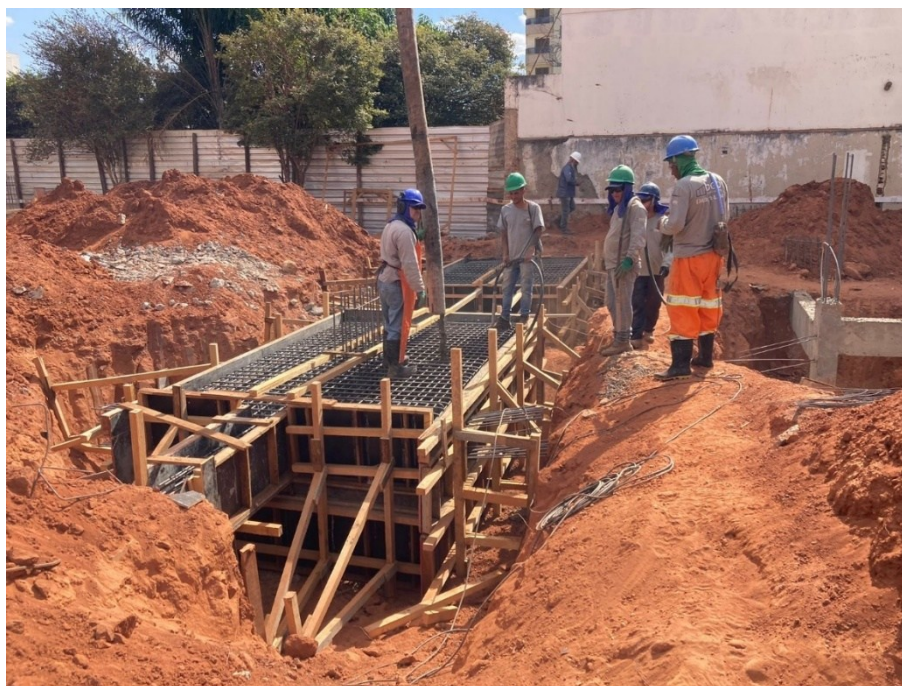
Figura 17: Concretagem dos blocos principais
