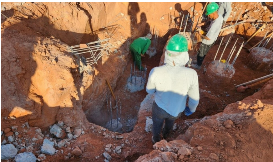
Figura 15: Escavação e arrasamento das estacas adicionais A1 e A2 e, E1 e E2
