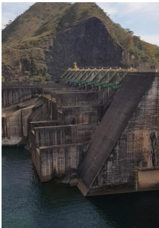
Figura 30 - Foto aproximada do vertedouro, identificando sua estrutura irregular.
