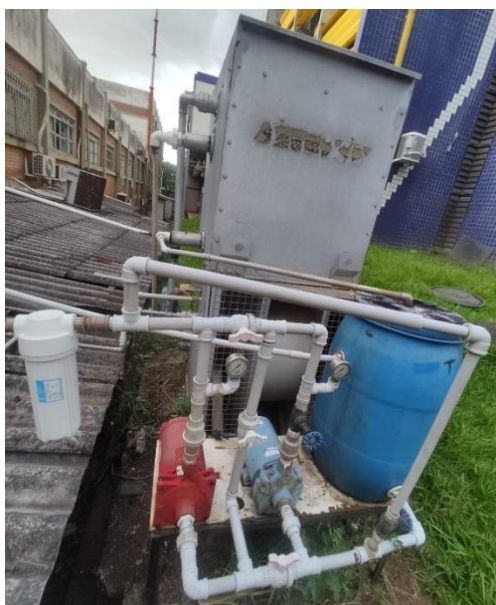
Figura 3.13 Circuito secundário de arrefecimento: a) torre de resfriamento evaporativa e b) variador de frequência.
