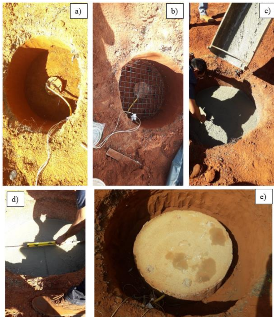
Figura C5 – Execução da sapata: a) Escavação; b) posicionamento da armadura; c) concretagem da sapata; d) escavação lateral.
