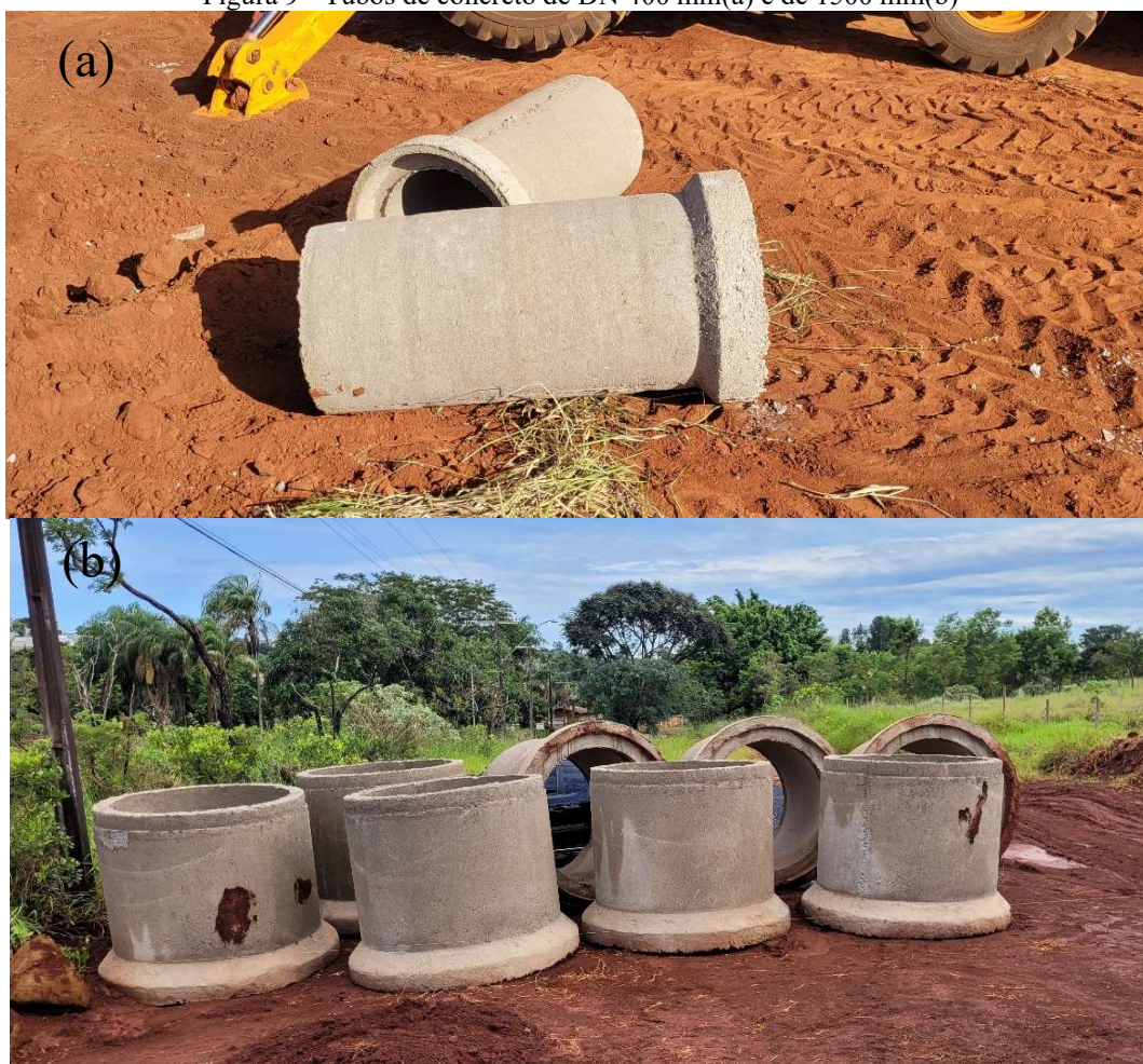
Figura 9 - Tubos de concreto de DN 400 mm(a) e de 1500 mm(b)
