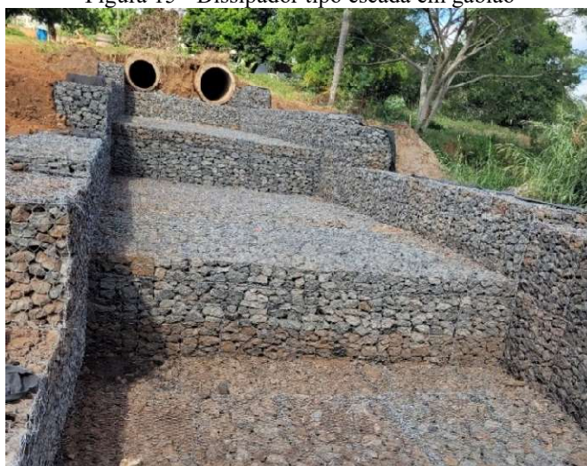
Figura 15 - Dissipador tipo escada em gabião
