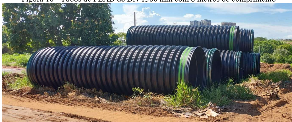
Figura 10 - Tubos de PEAD de DN 1500 mm com 6 metros de comprimento
