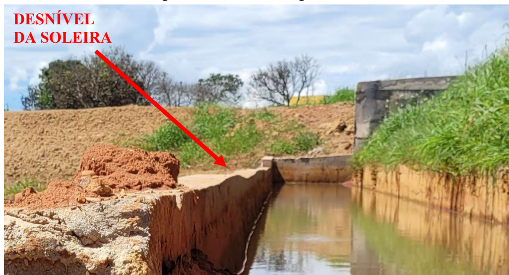
Figura 46 – Desnível ao longo da soleira
