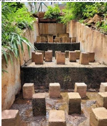
Figura 14 - Escada hidráulica com defletores
