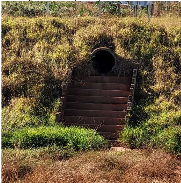
Figura 11 - Dissipador tipo escada hidráulica
