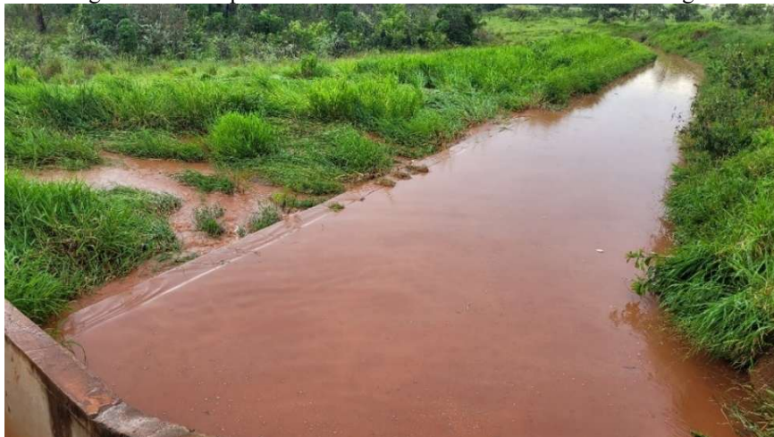
Figura 18 - Dissipador de soleira com canal cheio e vertendo a água
