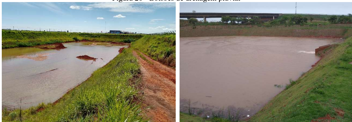
Figura 20 - Bolsões de drenagem pluvial
