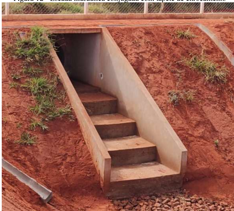
Figura 12 - Escada hidráulica conjugada com tapete de enrocamento
