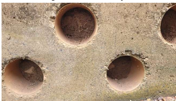
Figura 49 – Dreno entupido
