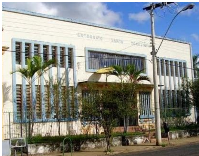
Figura 2 - Fachada do prédio do Colégio Externato Santa Terezinha.
