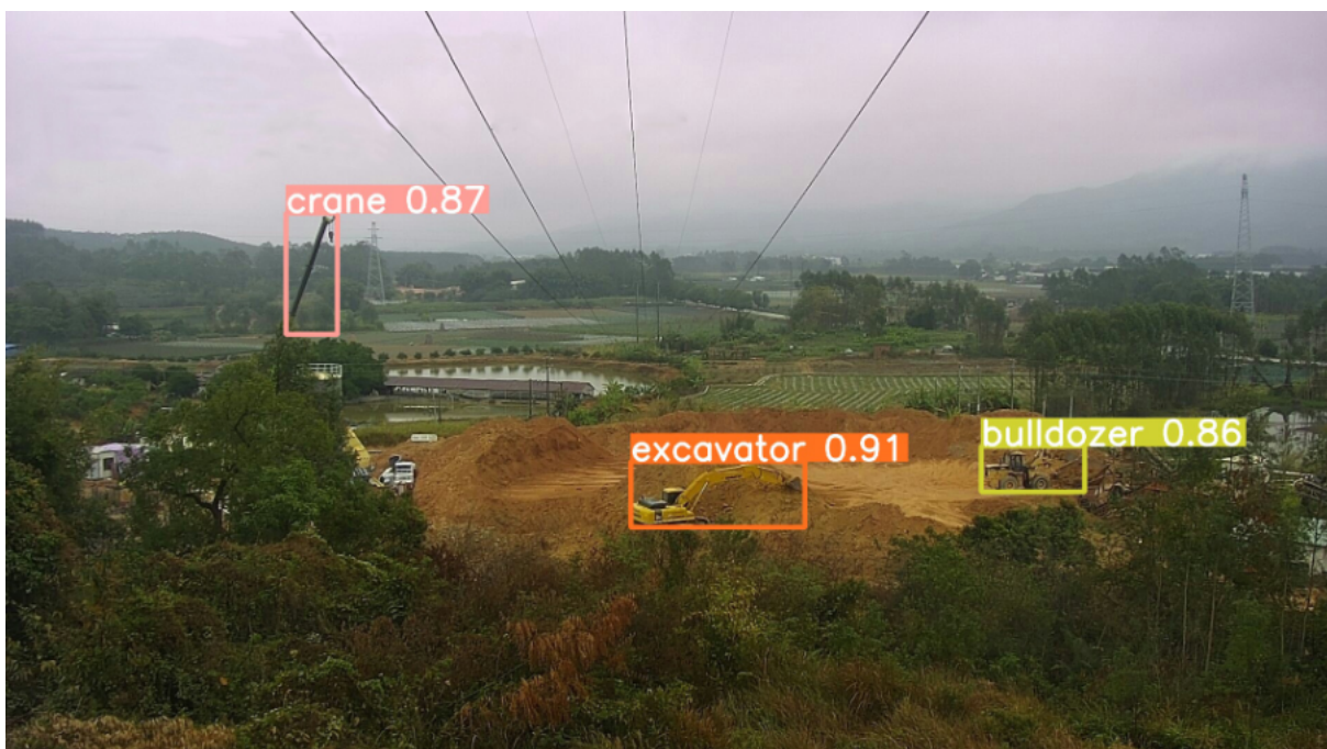
Figura 31 – Detecção de máquinas de construção próximas a linhas de transmissão (ZOU et al., 2024).
