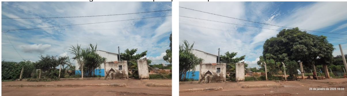
Figura 27 – Entrada principal do Ecoponto Santa Rosa
