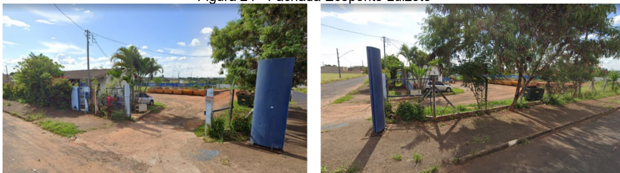
Figura 24 - Fachada Eco ponto Luizote
