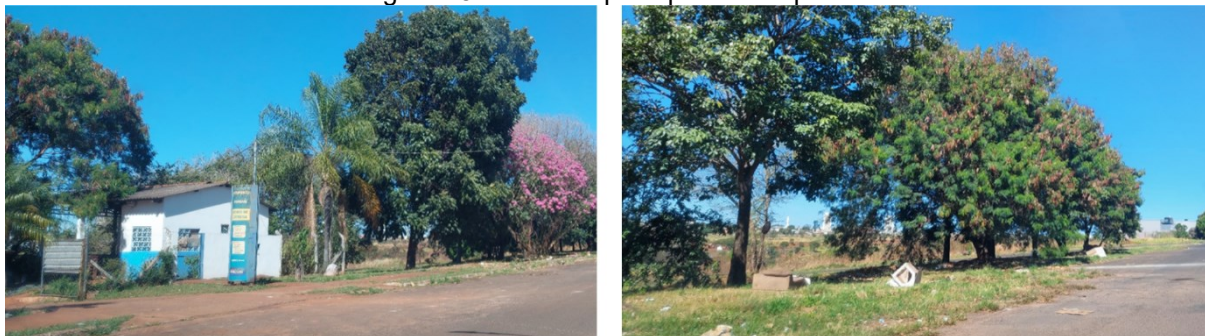
Figura 28 – Entrada principal do Ecoponto
