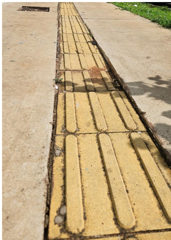
Figura 23. Piso tátil afundado, com desnível Acervo pessoal, 2024.
