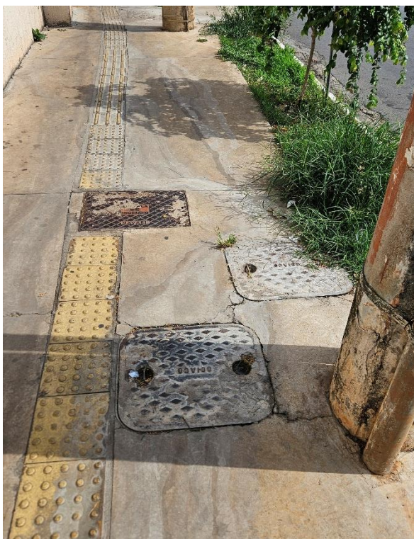
Figura 32. Caixas de passagem na circulação e interrompendo o piso tátil. Acervo pessoal, 2024.
