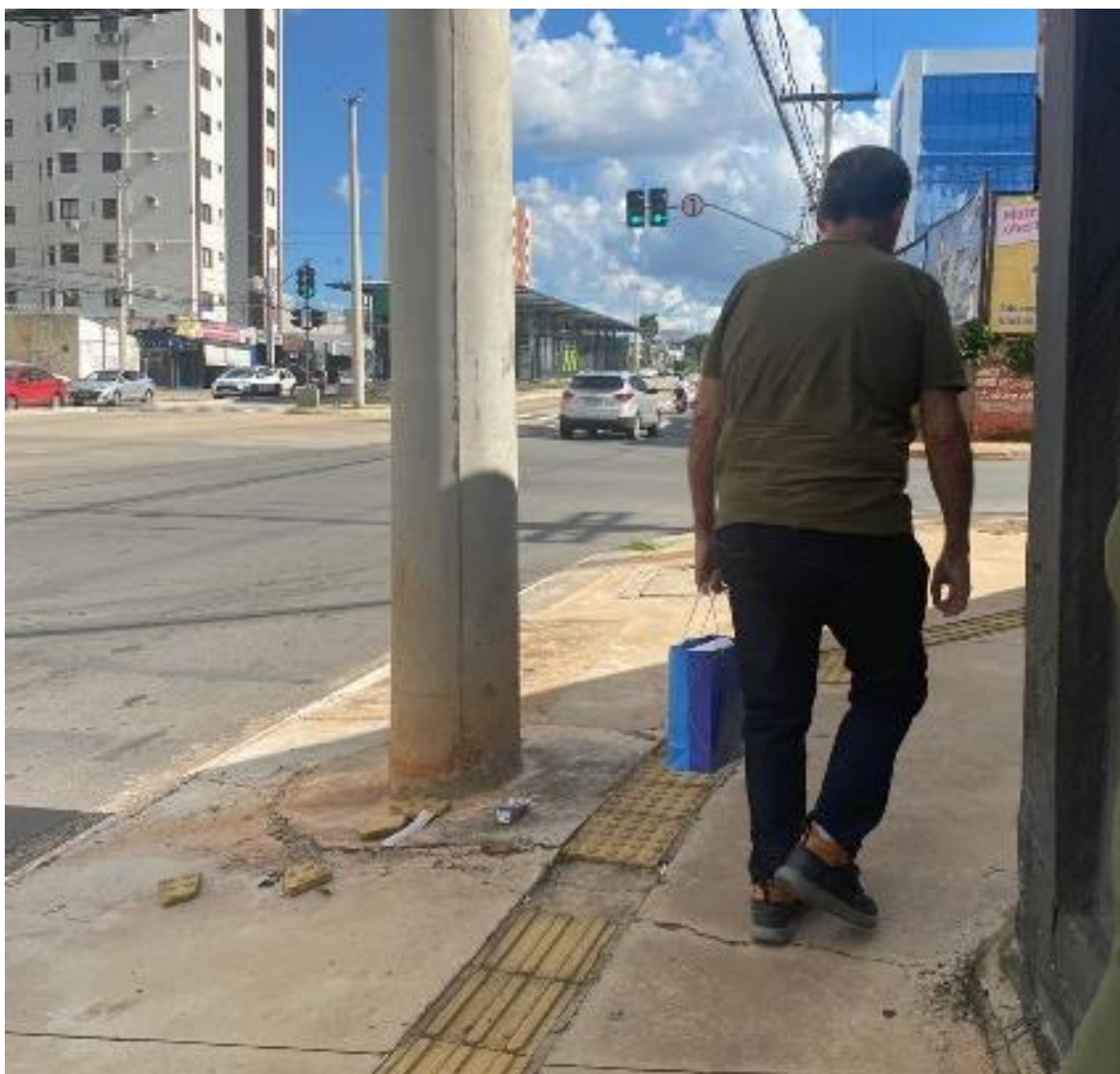
Figura 123. Poste muito próximo da sinalização tátil e piso tátil quebrado. Acervo pessoal, novembro de 2024.
