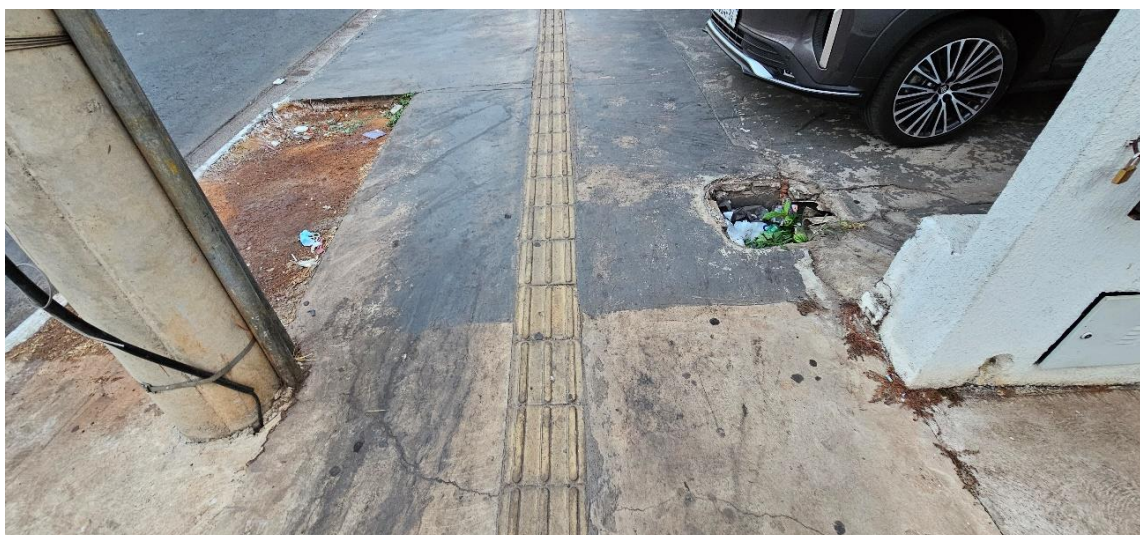
Figura 80. Caixa de passagem sem tampa. Acervo pessoal, 2024.
