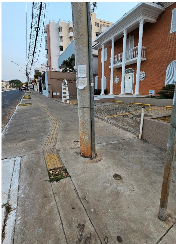
Figura 74. Piso tátil interrompido. Acervo pessoal, 2024.
