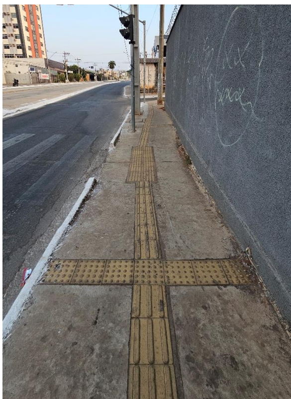
Figura 41. Rebaixamento lateral no calçamento. Acervo pessoal, 2024.
