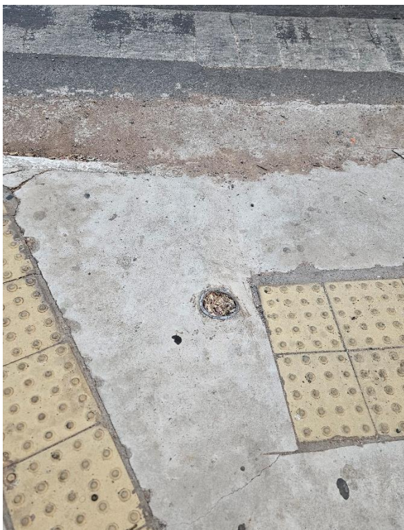
Figura 66. Buraco no rebaixo do meio-fio. Acervo pessoal, 2024.
