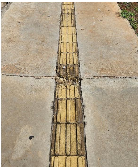
Figura 91. Piso tátil danificado. Acervo pessoal, 2024.
