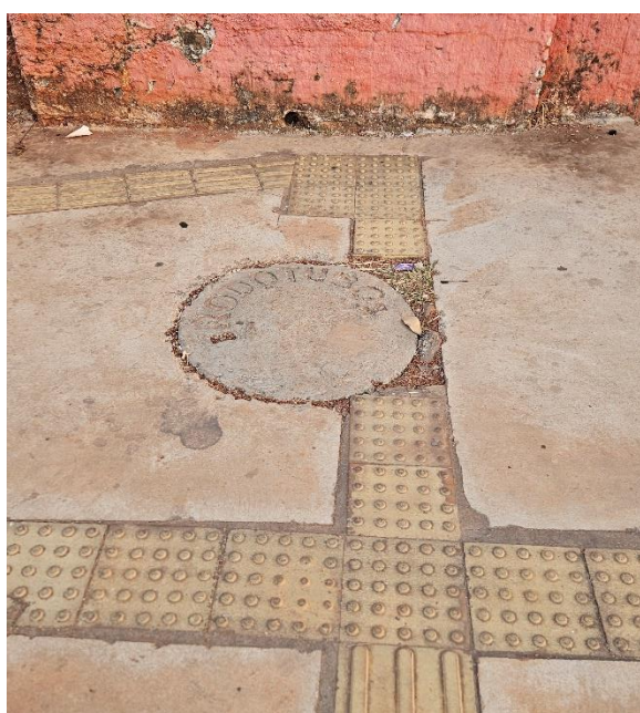
Figura 38. Caixa de passagem no piso tátil e instalação de piso tátil direcional na diagonal. Acervo pessoal, 2024.
