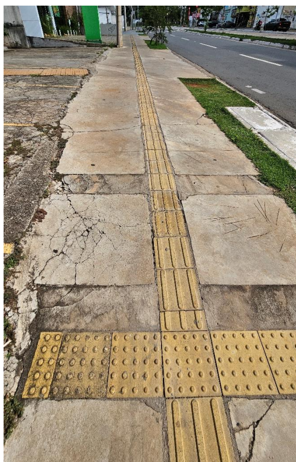
Figura 101. Calçamento quebrado. Acervo pessoal, 2024.
