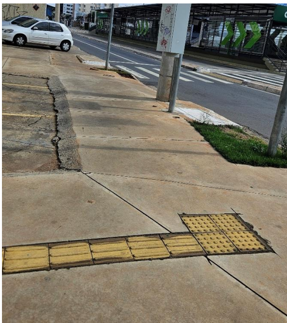
Figura 49. Piso tátil interrompido e desnível para vagas de estacionamento. Acervo pessoal, 2024.
