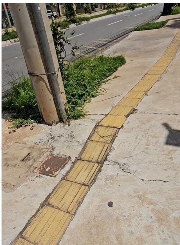
Figura 76. Calçamento com desnível e piso tátil danificado. Acervo pessoal, 2024.
