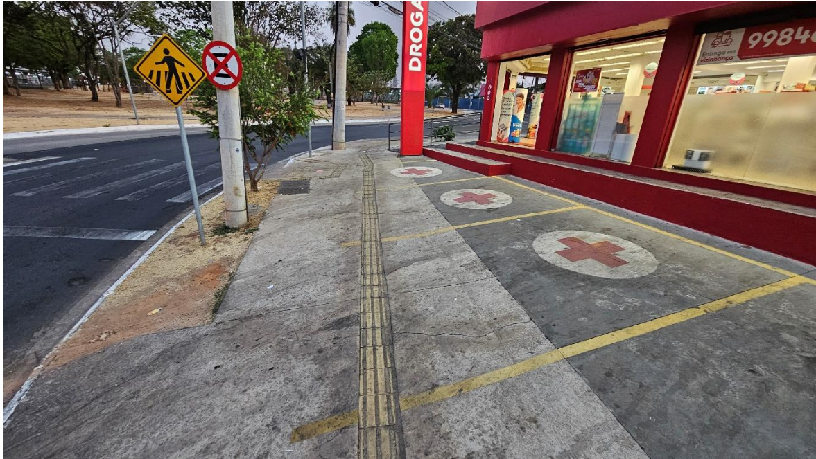
Figura 110. Vagas de estacionamento na faixa de circulação, em cima do piso tátil. Acervo pessoal, 2024.
