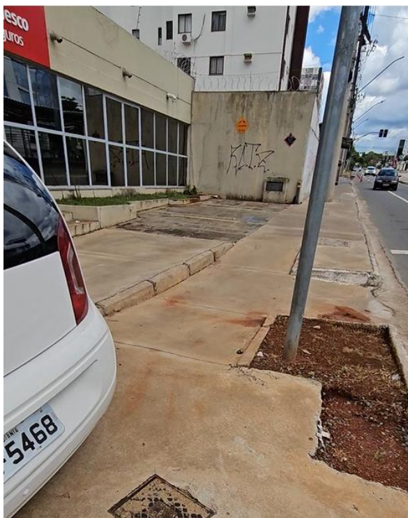
Figura 51. Rebaixamento lateral sem sinalização tátil. Acervo pessoal, 2025.
