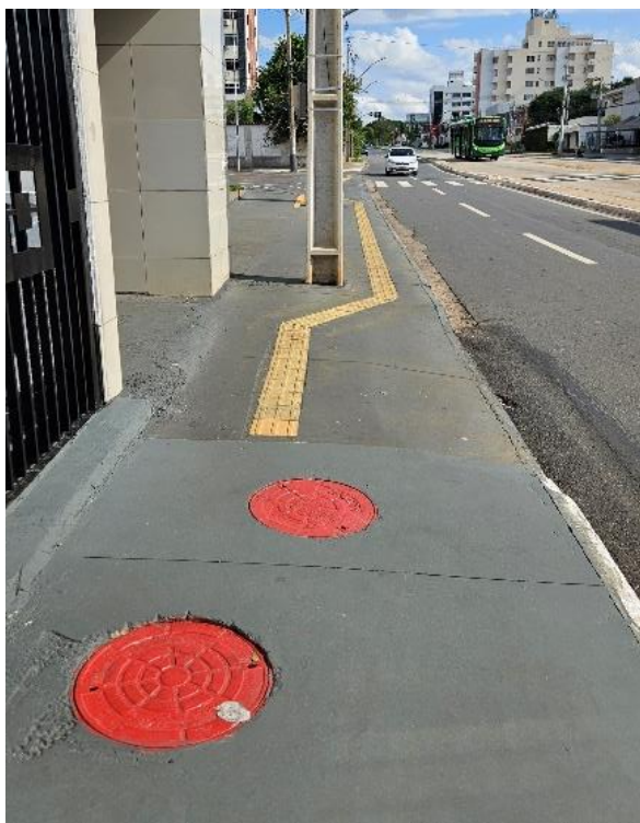
Figura 55. Piso tátil interrompido, caixas de passagem e postes na circulação. Acervo pessoal, 2024.
