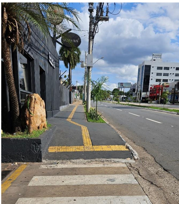
Figura 85. Piso tátil sem continuidade. Acervo pessoal, 2024.
