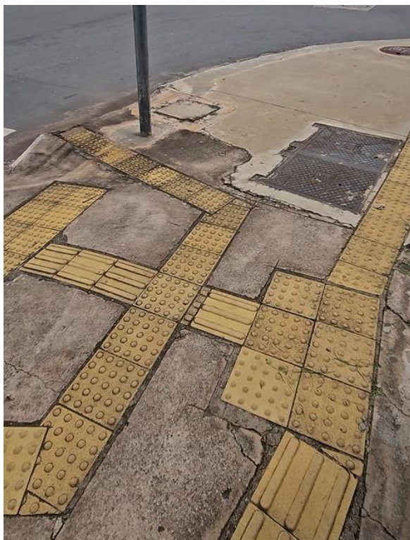
Figura 67. Caixa de passagem na circulação. Acervo pessoal, 2024.
