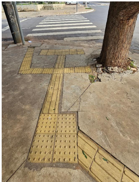
Figura 35. Calçamento quebrado e rebaixo de meio-fio com sinalização tátil incompleta. Acervo pessoal, 2024.
