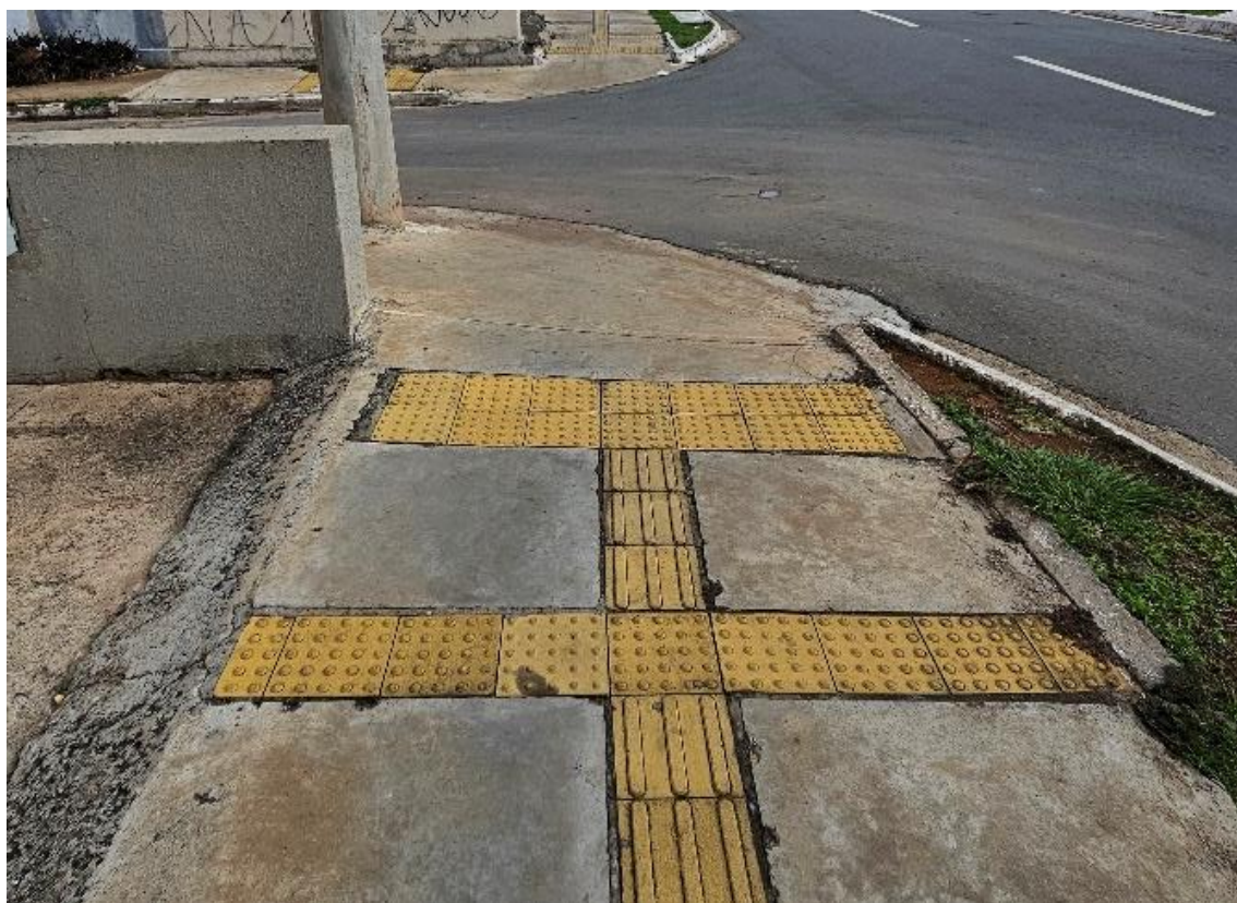
Figura 95. Rebaixo de meio-fio com sinalização tátil. Acervo pessoal, 2024.
