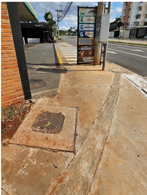
Figura 83. Caixa de passagem e placa na circulação. Acervo pessoal, 2024.
