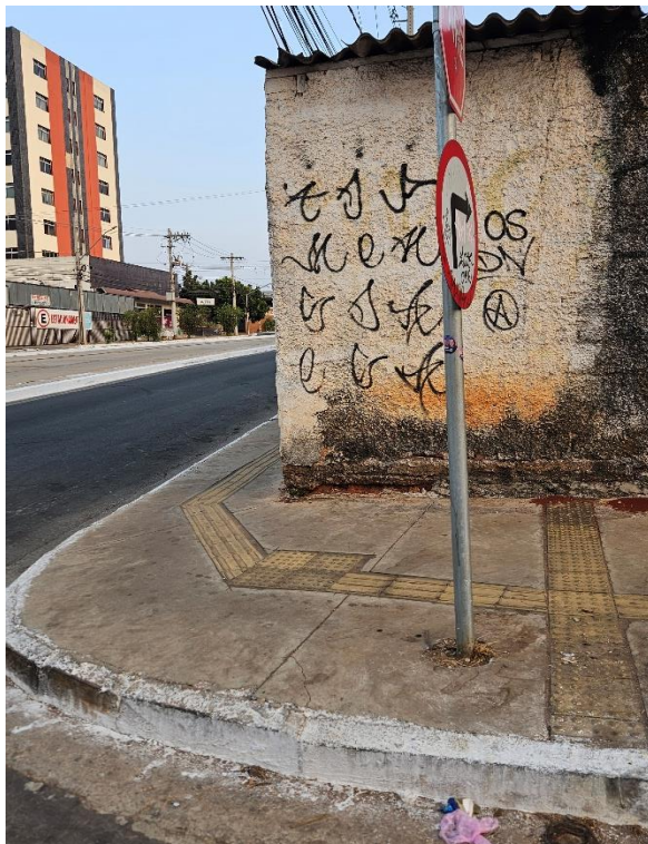
Figura 58. Faixa de circulação de 1,20m de largura. Acervo pessoal, 2024.
