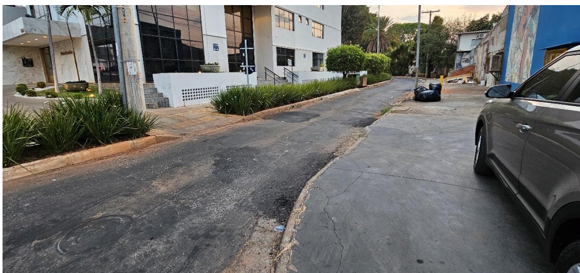
Figura 82. Rebaixo de meio fio (à direita) sem sinalização tátil. Acervo pessoal, 2024.
