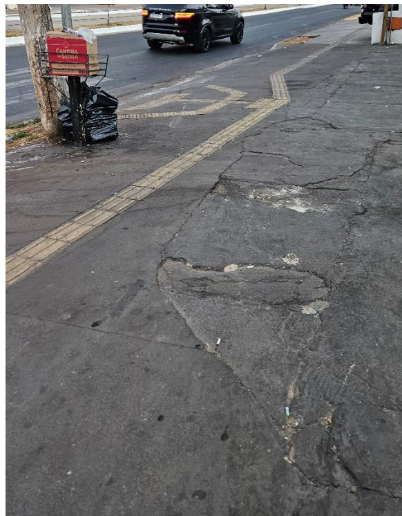
Figura 105. Piso do calçamento com trepidações. Acervo pessoal, 2024.
