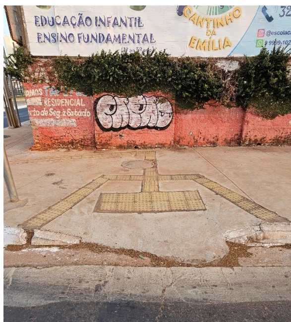
Figura 37. Rebaixo de meio fio com pequeno desnível na sarjeta e caixa de passagem no piso tátil. Acervo pessoal, 2024.
