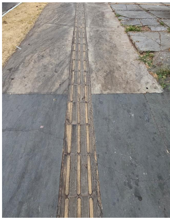
Figura 107. Calçamento em cores diferentes e piso tátil manchado. Acervo pessoal, 2024.
