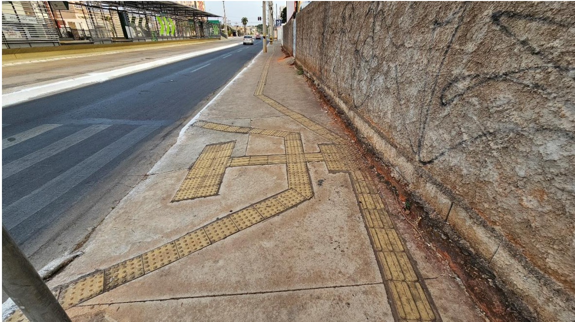
Figura 39. Rebaixo de meio fio para pedestres aplicado de forma errônea. Acervo pessoal, 2024.
