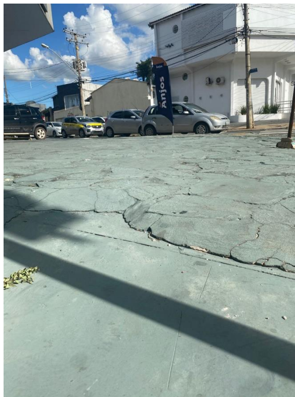
Figura 102. Piso trepidante. Acervo pessoal, 2024. Figura 103. Desnível acentuado no piso adjacente. Acervo pessoal, 2024.
