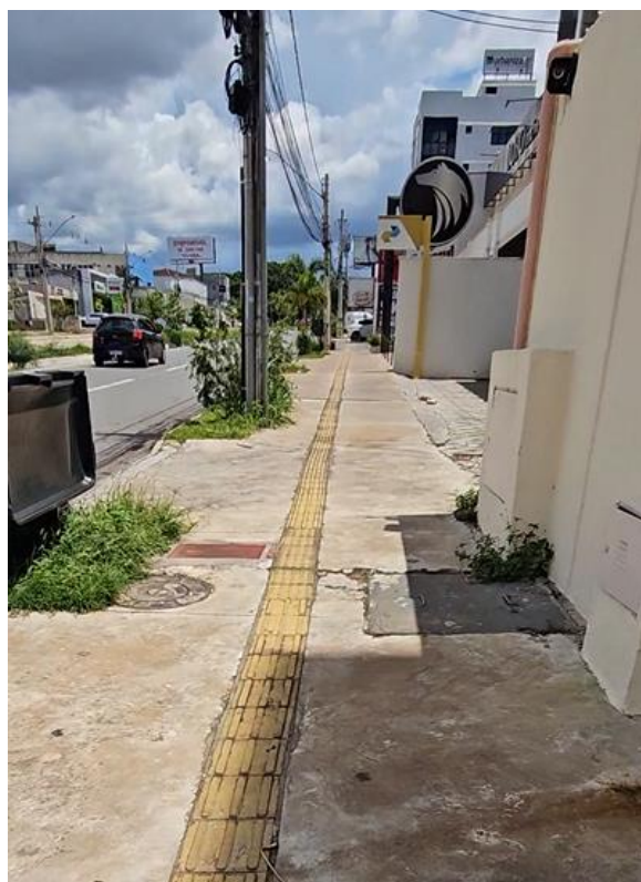
Figura 77. Caixas de passagem na circulação. Acervo pessoal, 2024.
