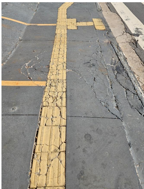
Figura 53. Piso tátil e adjacente quebrados. Acervo pessoal, 2024
