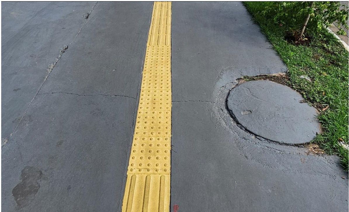
Figura 36. Aplicação incorreta do piso tátil de alerta. Acervo pessoal, 2024.
