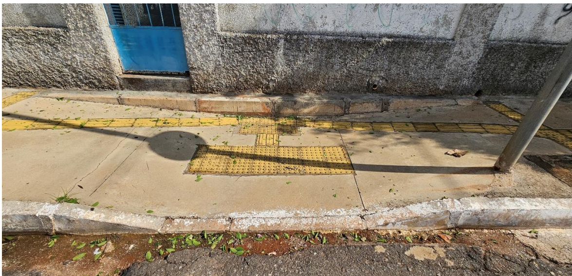
Figura 70. Rebaixamento lateral com sinalização tátil incorreta. Acervo pessoal, 2024.
