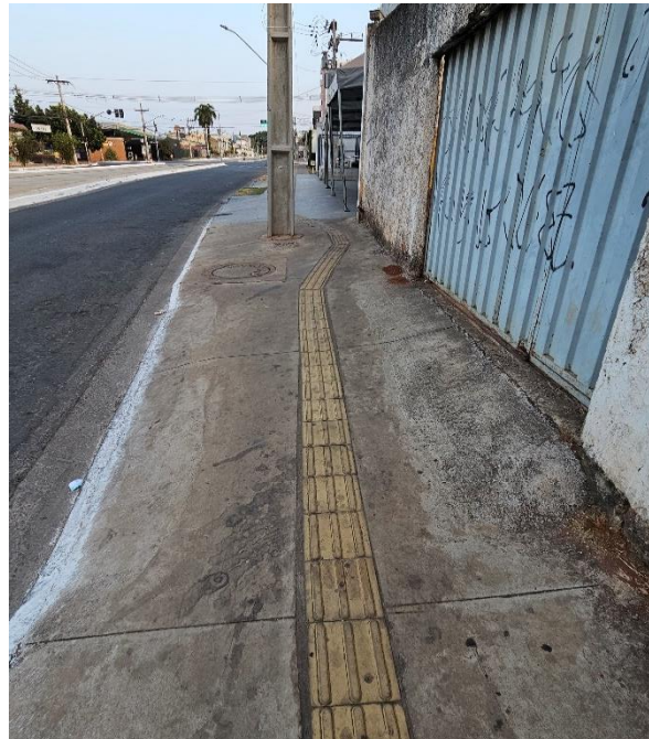
Figura 63. Faixa de circulação com rebaixo de meio fio, caixa de passagem e poste. Acervo pessoal, 2024.
