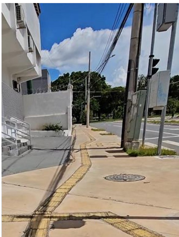
Figura 111. Caixa de passagem na circulação. Acervo pessoal, 2024.
