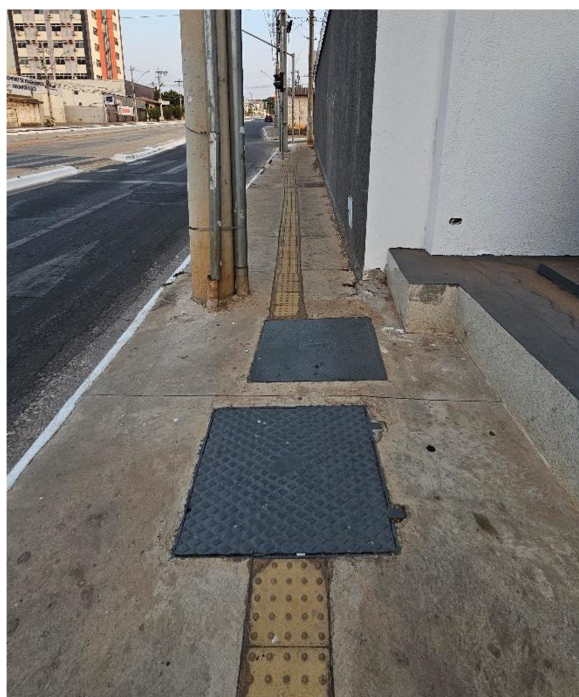
Figura 46. Caixas de passagem na circulação e área livre de 1,00 m entre o poste e o limite da edificação. Acervo pessoal, 2024.
