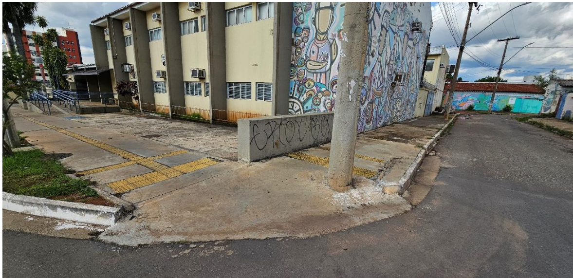
Figura 96. Rebaixo de meio-fio com sinalização tátil aplicada de forma errada. Acervo pessoal, 2024.
