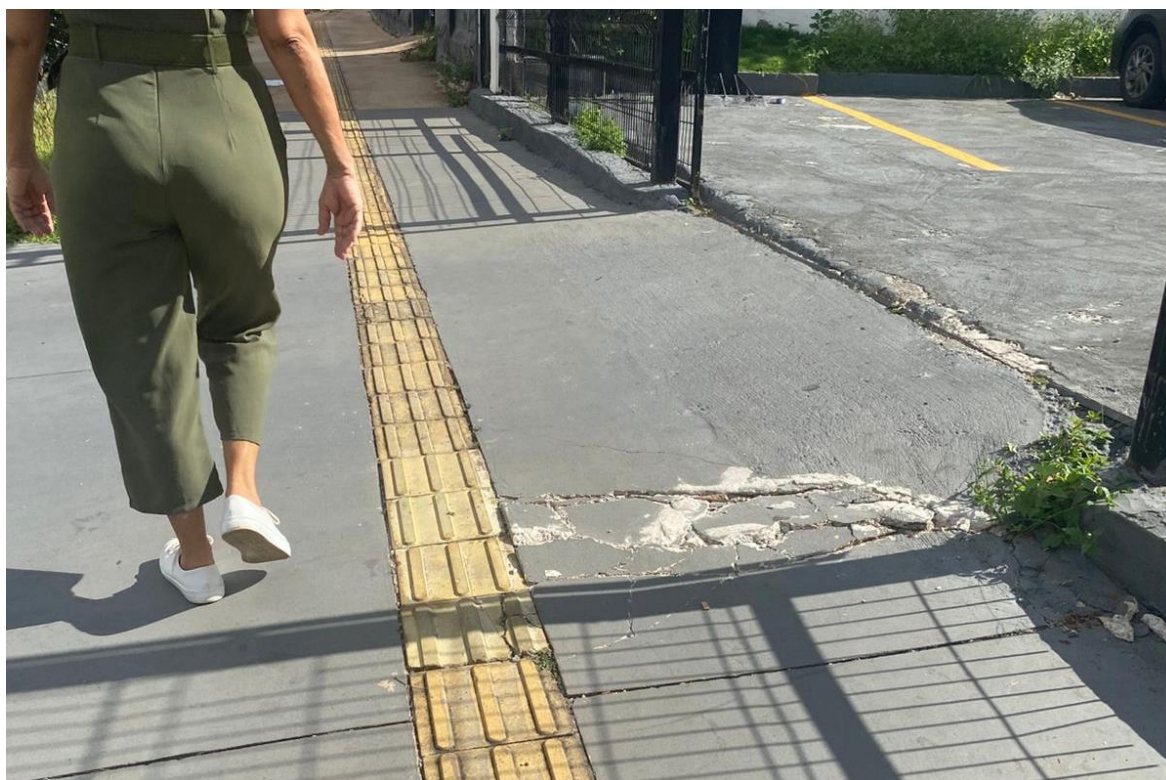
Figura 31. Rampa para estacionamento na faixa de circulação. Acervo pessoal, 2024.
