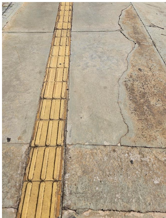
Figura 33. Calçamento com rachaduras. Acervo pessoal, 2024.
