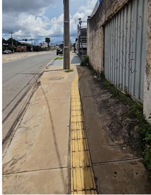
Figura 61. Rampa ocupando parte da circulação. Acervo pessoal, 2024.
