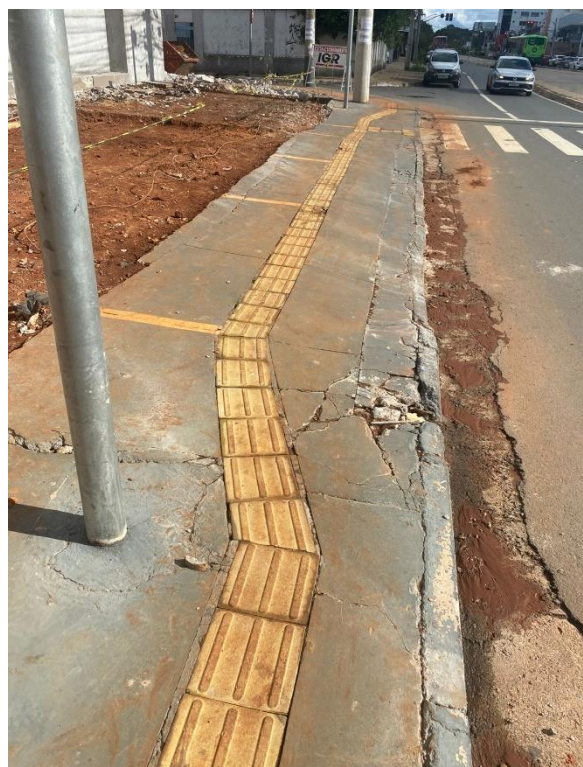
Figura 54. Calçamento danificado devido à reforma do estabelecimento. Acervo pessoal, 2025.
