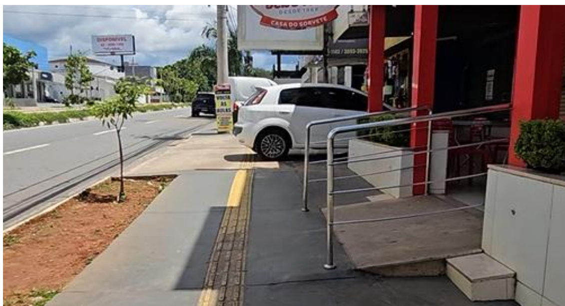
Figura 81. Rampa de estabelecimento invadindo a área de circulação. Acervo pessoal, 2024.
