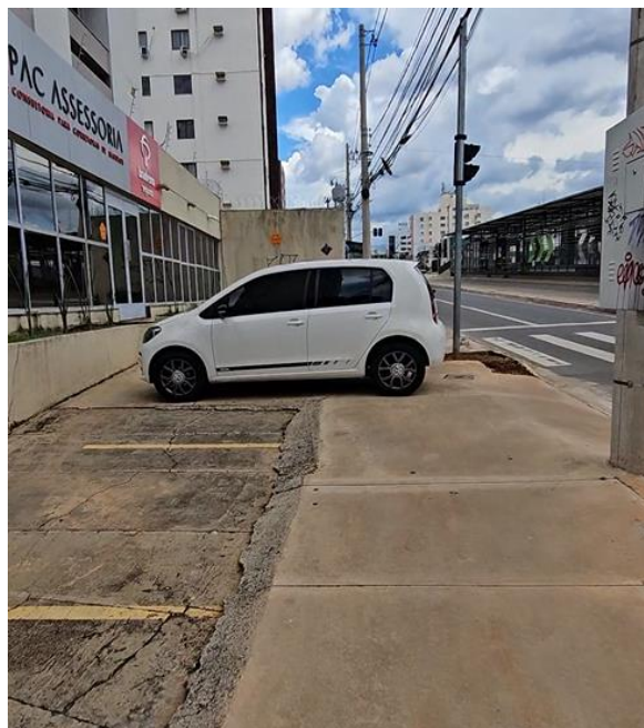
Figura 50. Desnível no calçamento para vagas de veículos. Acervo pessoal, 2025.
