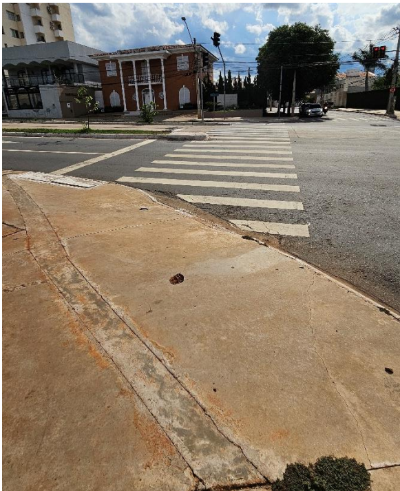
Figura 87. Rebaixo de meio-fio sem sinalização tátil. Acervo pessoal, 2024.
