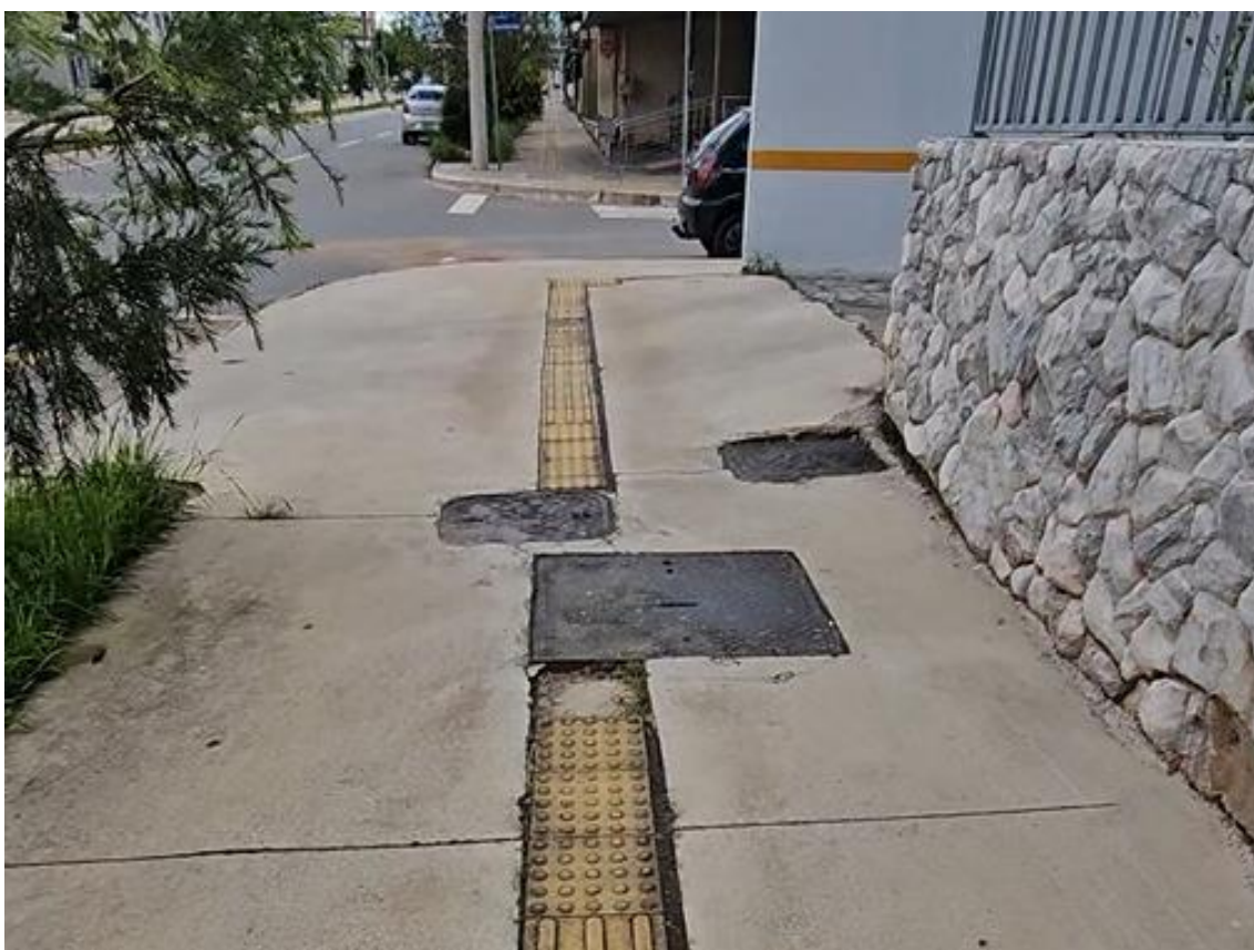
Figura 21. Caixas de passagem interrompendo o piso tátil. Acervo pessoal, 2024.
