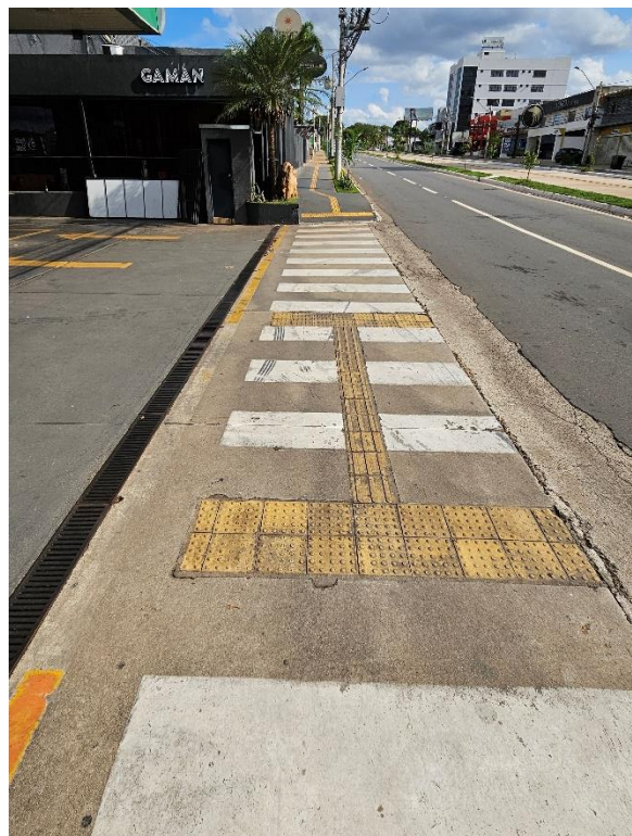
Figura 84. Piso tátil sem continuidade. Acervo pessoal, 2024.
