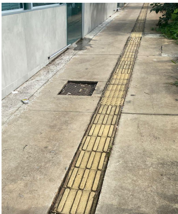
Figura 143. Caixa de passagem afundada que ocasionou tropeço. Acervo pessoal, novembro de 2024.
