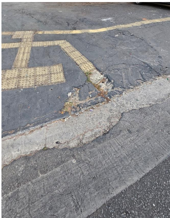
Figura 104. Pisos tátil e adjacente quebrados. Acervo pessoal, 2024.
