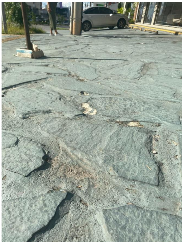
Figura 102. Piso trepidante. Acervo pessoal, 2024. Figura 103. Desnível acentuado no piso adjacente. Acervo pessoal, 2024.
