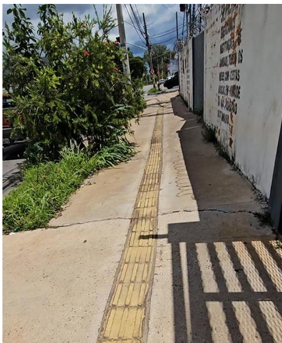
Figura 92. Vegetação invadindo a circulação e calçamento com rachadura. Acervo pessoal, 2024.
