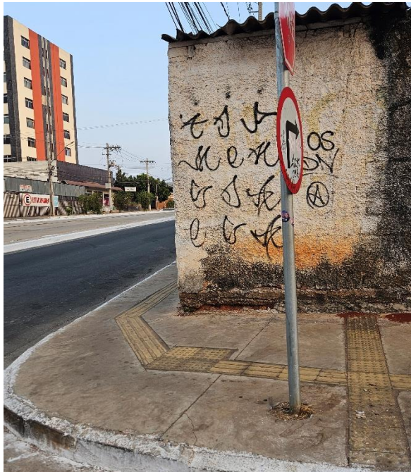
Figura 62. Faixa de circulação de 1,20m de largura. Acervo pessoal, 2024.
