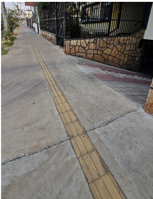
Figura 29. Desnível transversal na entrada de garagem. Acervo pessoal, 2024.
