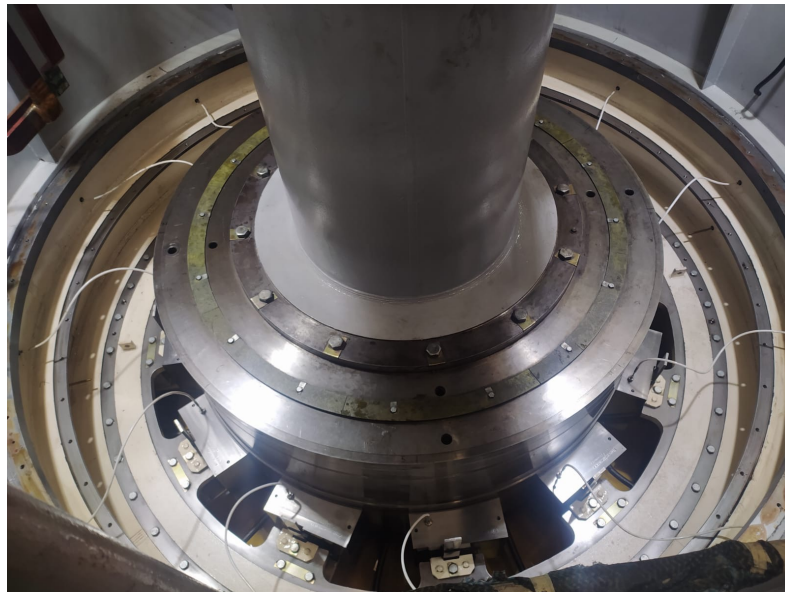
Figura 3.5: Mancel segmentado radial.
