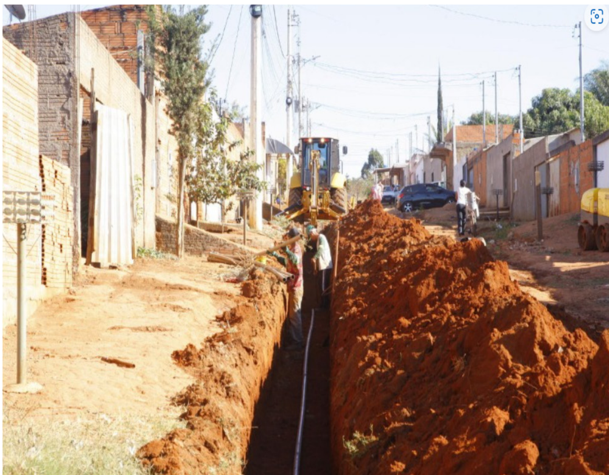
FIGURA 33: Obras de instalação de rede de água potável
