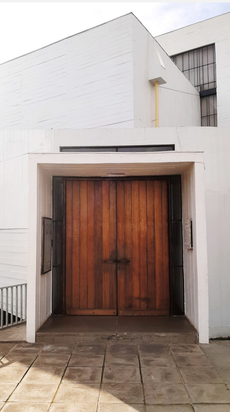
Figura 42 – Porta de acesso à Igreja do Monastério Beneditino de Las Condes (foto do dia 25 de julho de 2024, às 10:31).
