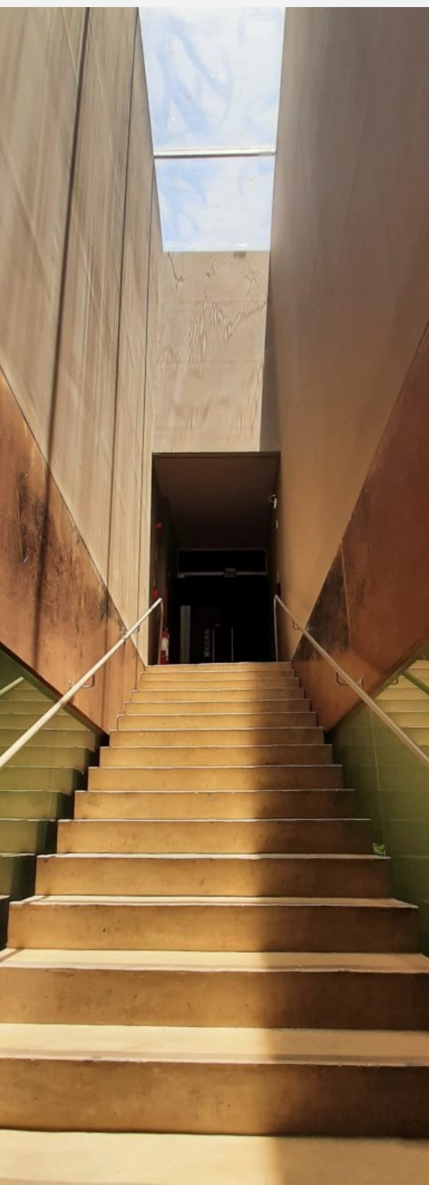
Figura 29 – Escada de acesso à exposição da Galeria Miguel Rio Branco (Instituto Inhotim) , projetada pelo escritório Arquitetos Associados e concluída em 2010.
