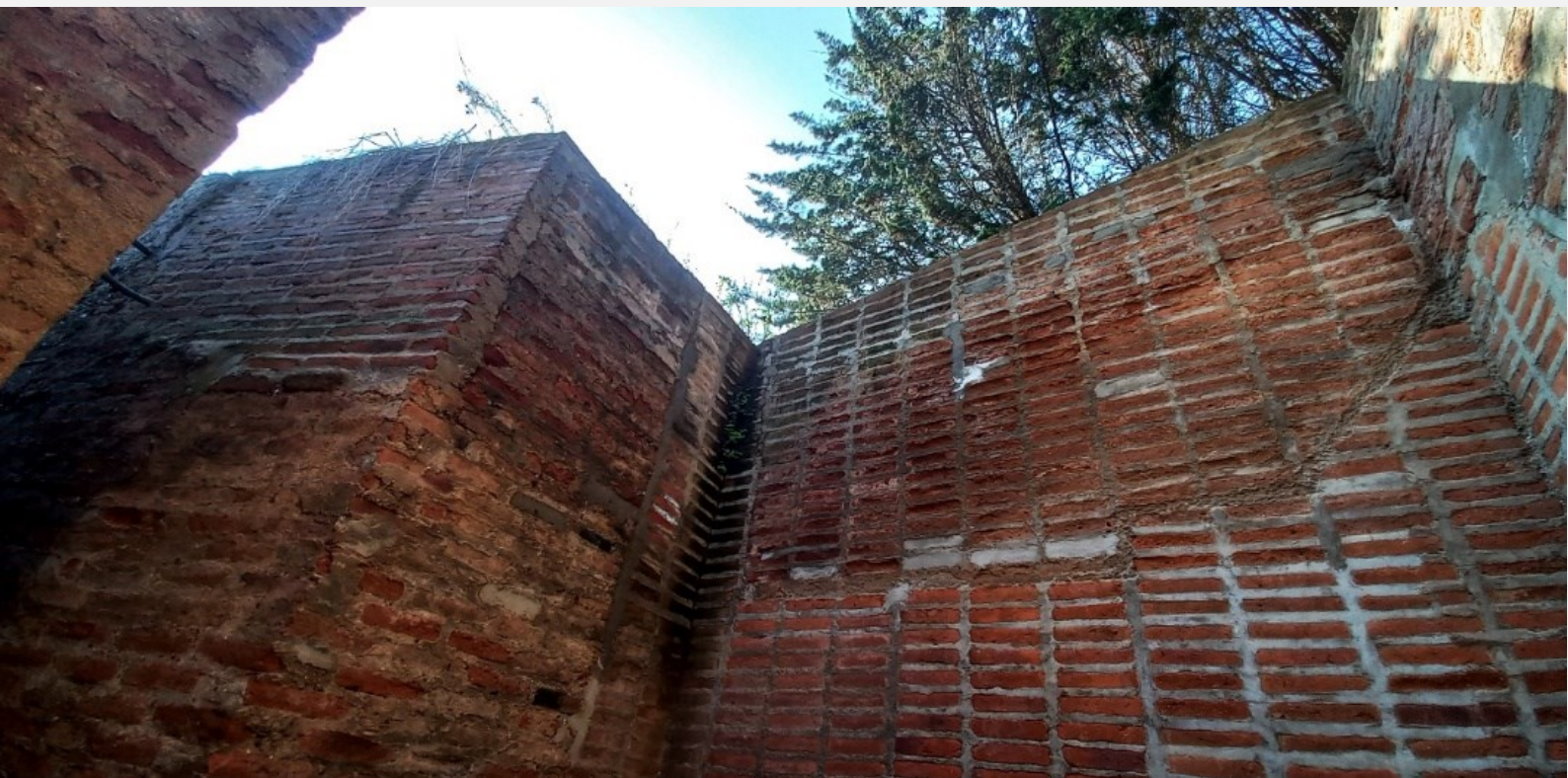
Figura 33 – Câmara aberta do Poço Escultórico na Cidade Aberta (foto do dia 22 de julho de 2024, às 11:13).
