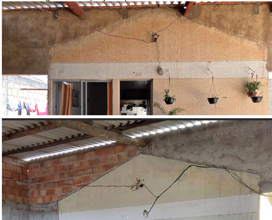
Figura 72 - Ampliações apoiando na estrutura do embrião
