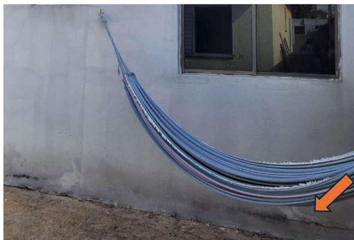
Figura 79 - Patologia devido a infiltração
