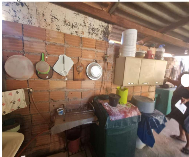
Figura 86 - Parede sem amarração e acabamentos
