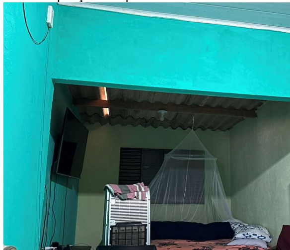
Figura 52 - Ampliação de quarto com cobertura mal instalada
