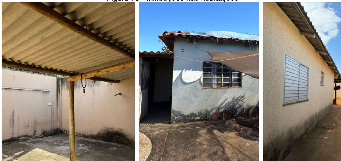
Figura 75 - Infiltrações nas habitações
