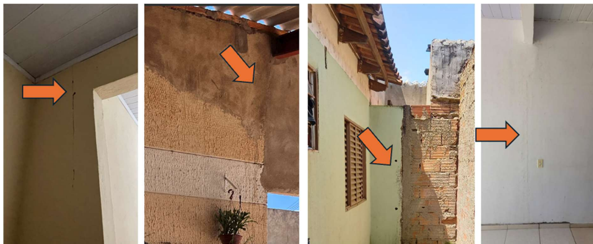
Figura 78 - Fissuras por dilatação térmica
