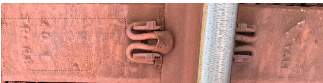
Figura 2 – Fissuras longitudinais na face do dormente, destacadas pelas linhas pontilhadas.
