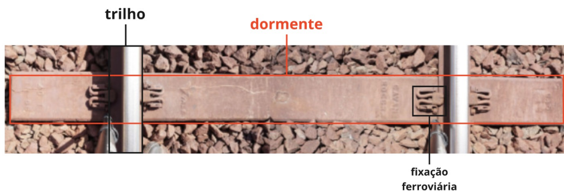
Figura 1 – Dormente de concreto protendido, e principais estruturas.
