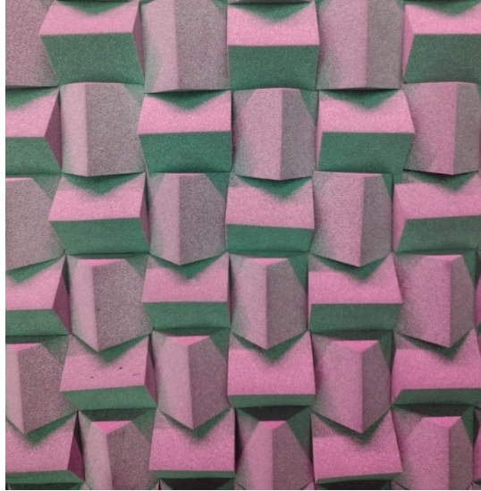
Figura 5.7 - Espumas de isolamento acústico da cabine de ligações V4 Company - Domingues & CO. Fonte: do autor (2025).
