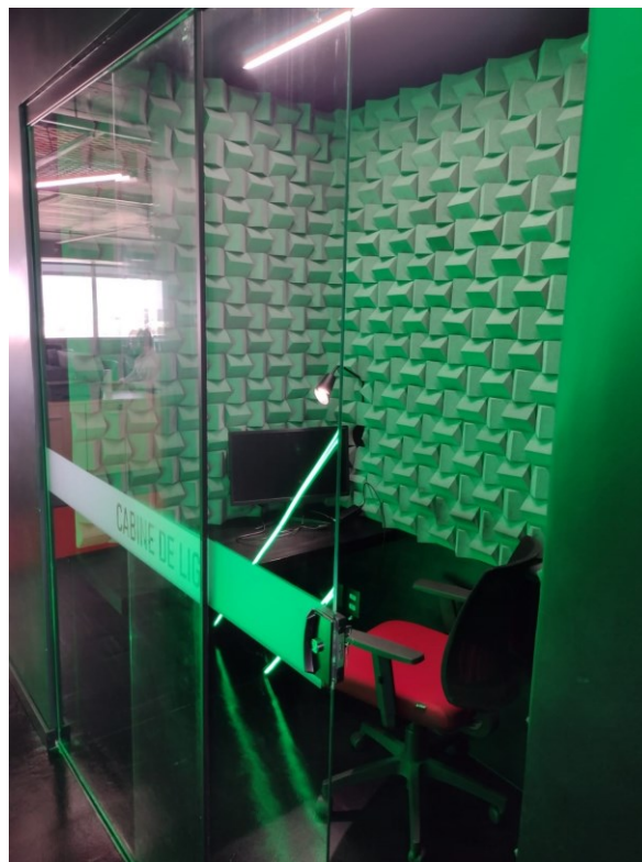
Figura 5.5 - Cabine de ligações V4 Company - Domingues & CO (Entrada). Fonte: do autor (2025).
