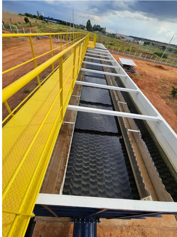
Figura 14 - Unidade de decantação de alta taxa.
