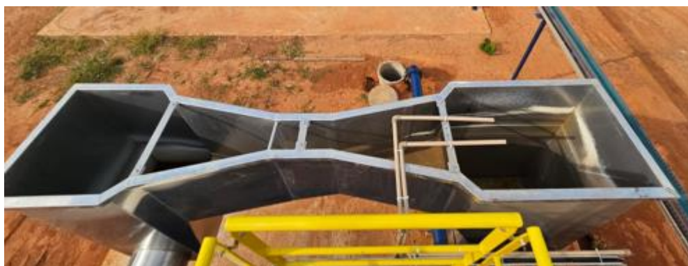
Figura 12 - Calha Parshall.
