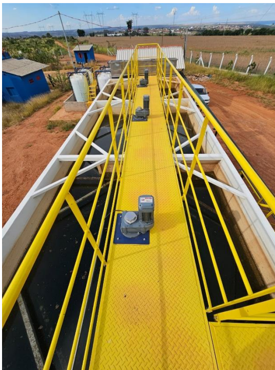
Figura 13 - Floculador mecanizado.
