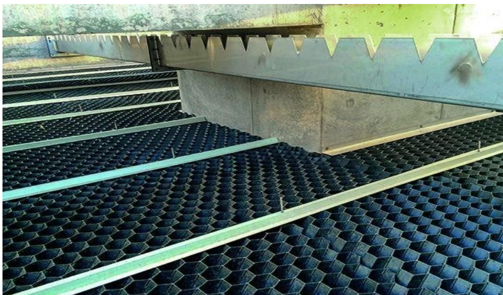
Figura 2 – Lamelas de decantação de alta taxa de seção hexagonal
