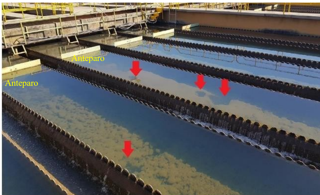
Figura 5 – Arraste de lodo a jusante dos anteparos dos decantadores de concreto
