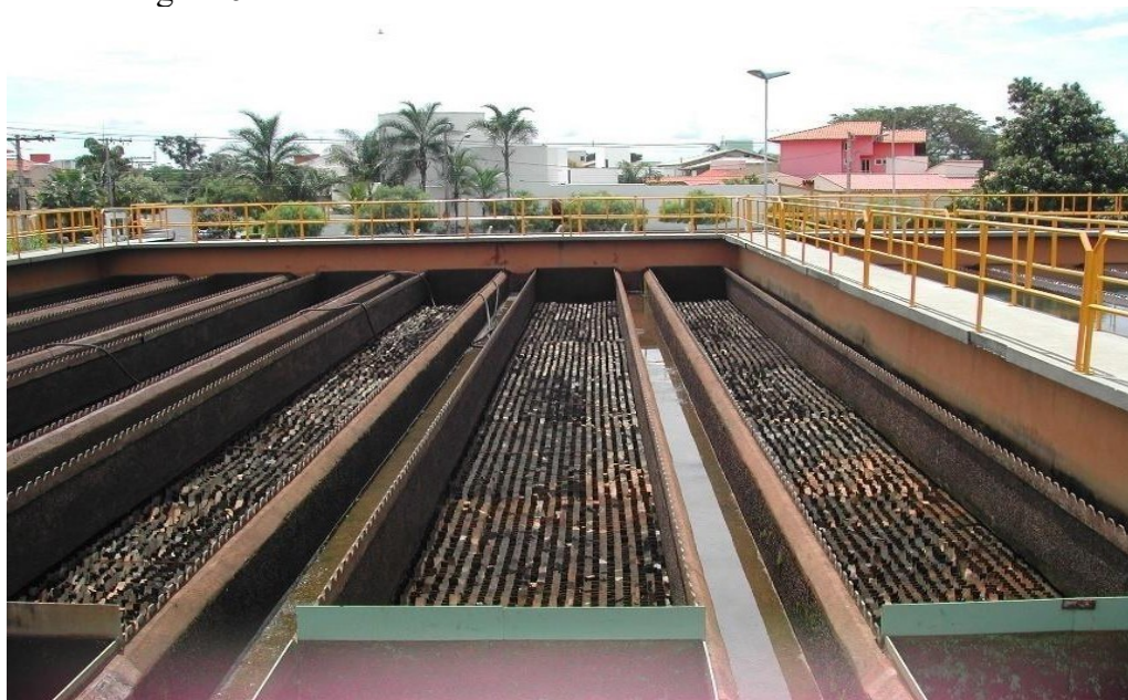
Figura 6 - Detalhes do decantador de concreto da ETA Bom Jardim
