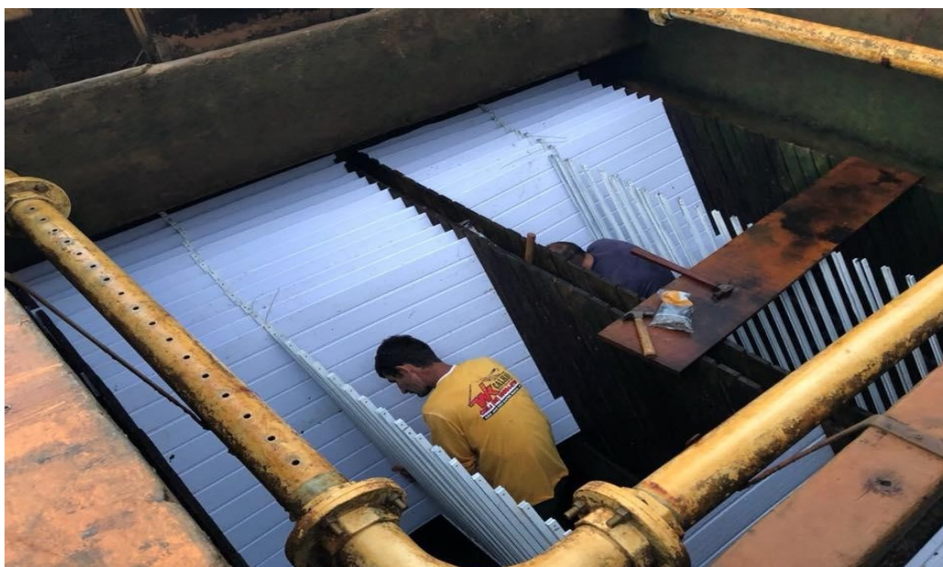
Figura 3 – Montagem de placas planas paralelas de decantação de alta taxa
