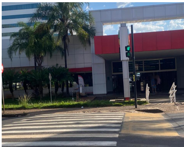
Figura 09: Travessia Elevada, Semáforo para Pedestres e Calçada em Boas Condições de conservação
