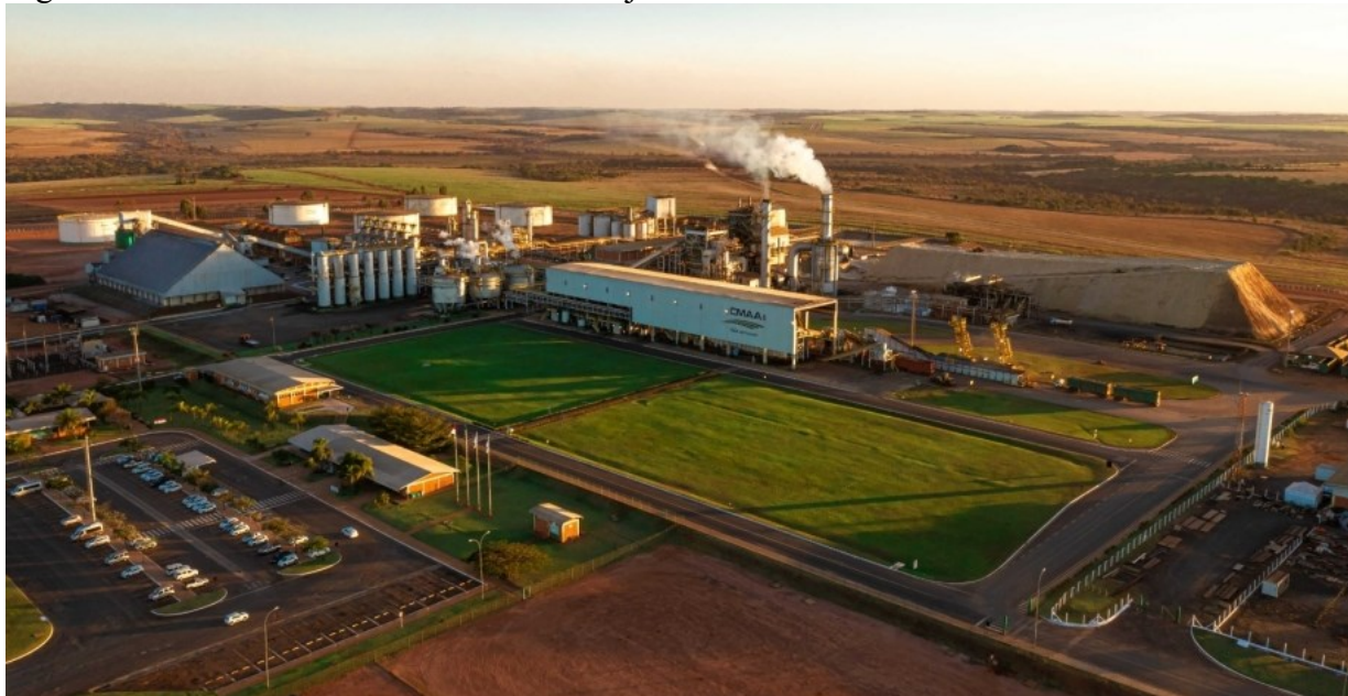
Figura 2.4 – Vista aérea da Usina Vale do Tijuco.
