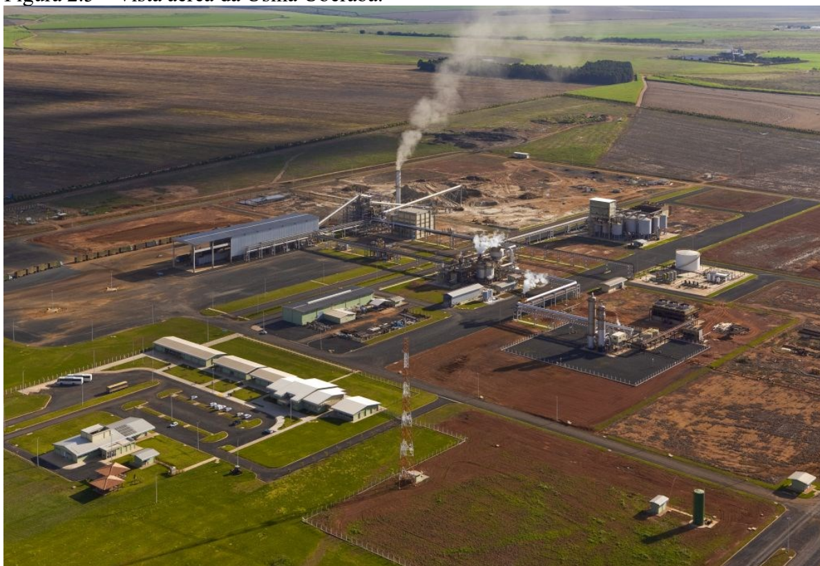
Figura 2.5 – Vista aérea da Usina Uberaba.
