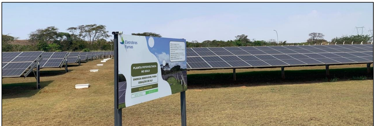
Figura 3.1: Sistema fotovoltaico utilizado para alimentação do eletrolisador. Fonte: Autoria própria.
