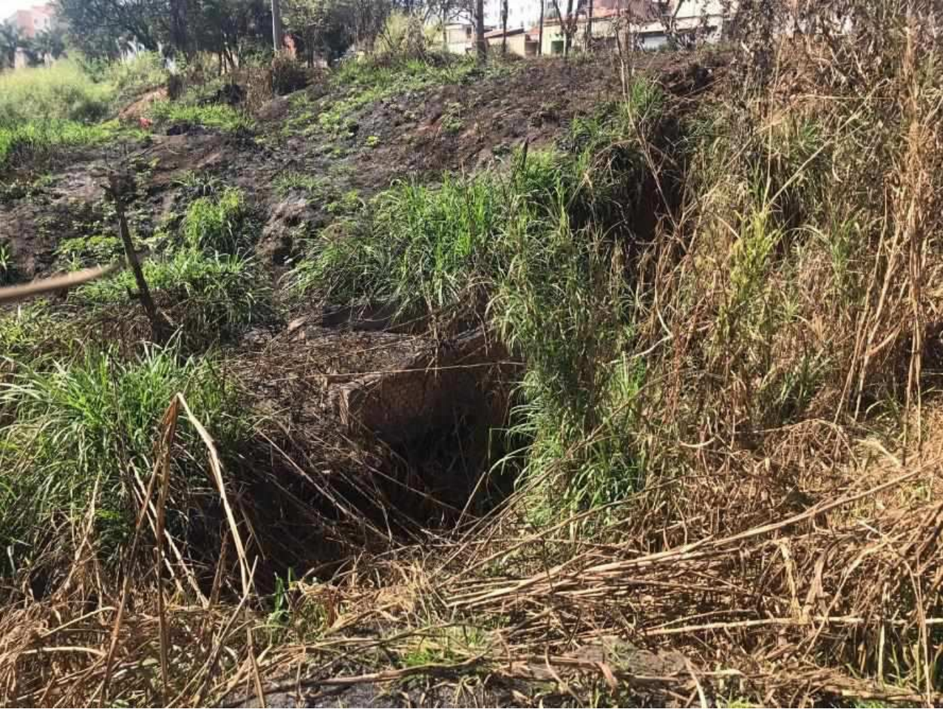
Ilustração erosão regressiva e ruínas de tubos e alvenarias do sistema de drenagem e lançamento pluvial. Fonte: Autoral.
