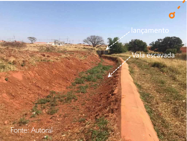
Imagens de dispositivos de lançamento pluvial e dissipação de energia implantados em regiões de várzea (MB-1). Fonte: Autoral.
