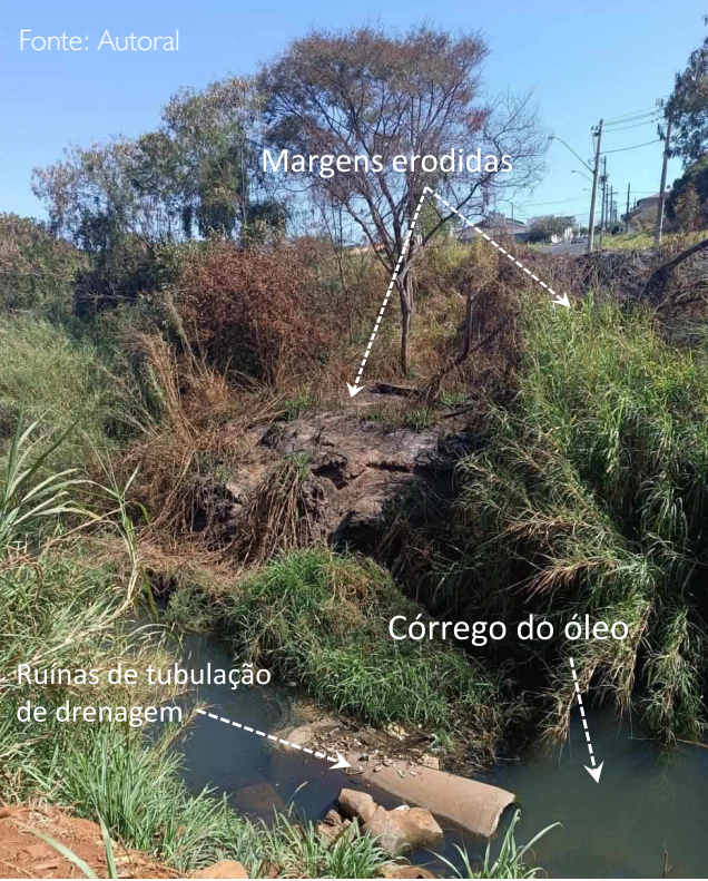
Ilustração dispositivo de lançamento pluvial implantado às margens do Córrego do Óleo e ruínas de tubos de drenagem.(MB-12). Fonte: Autoral.
