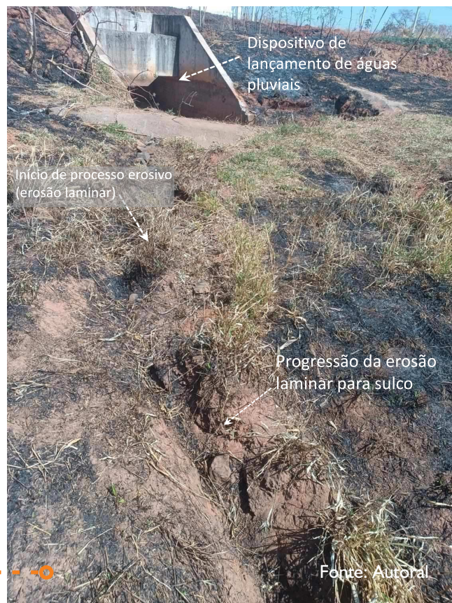
Ilustração dispositivo de lançamento pluvial e dissipação de energia implantado em regiões de várzea (MB-1). Fonte: Autoral.
