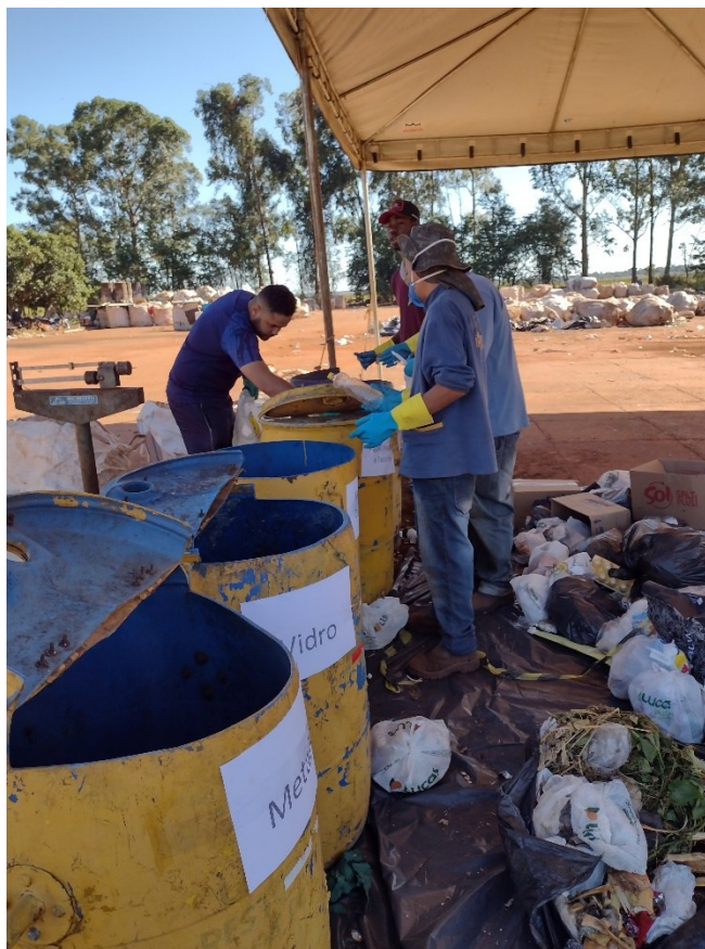
Figura 15 - Triagem dos resíduos domiciliares analisados na avaliação da composição gravimétrica.
