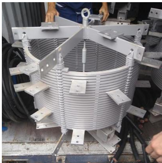
Figura 5.1 - Reator de núcleo de ar monofásico.
