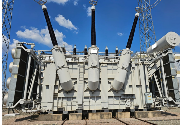
Figura 16 – Fotografia do transformador submetido ao ensaio EA.
