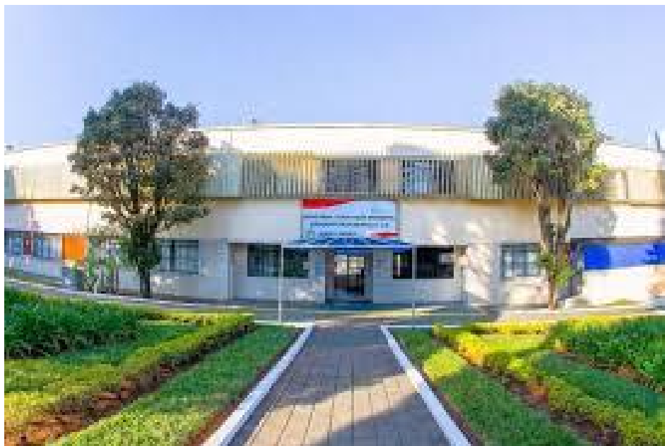
Figura 8: Fachada do Colégio Santa Maria em Londrina. Hoje Colégio Positivo
