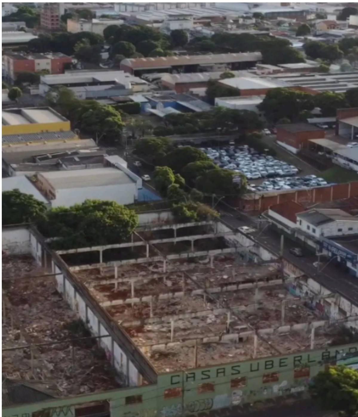
Figura 01 - Escombros do GALPÃO-DIY alguns dias após a demolição. Uberlândia/MG, maio de 2023. Fonte: Fotografia cedida pela produtora de vídeo Parafal Rec. maio de 2023.
