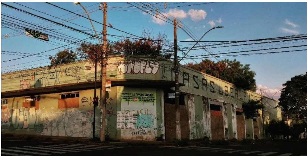
Figura 32 - Fachada do GALPÃO-DIY; esquina da avenida Floriano Peixoto com rua José Resende dos Santos. Uberlândia. Foto por Gustavo Silva. 2020.
