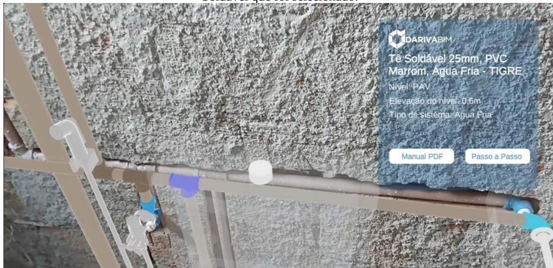
Figura 27. Modelo virtual sobreposto em uma parede hidráulica com a caixa de informações de um Tê Soldável que foi selecionado.
