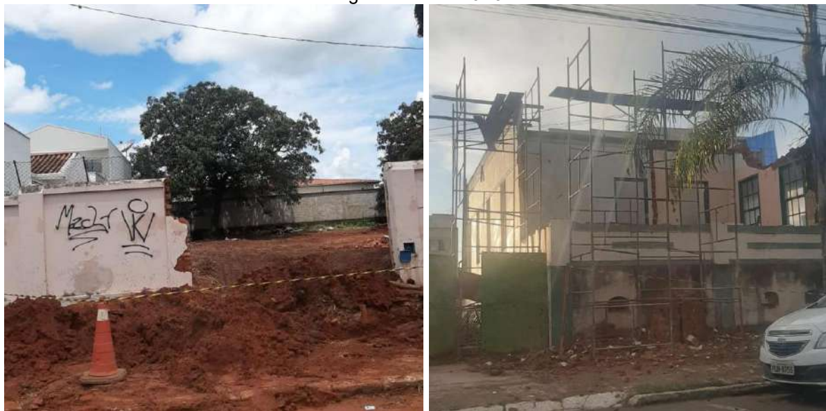
Figura 76 - Demolições da residência da Família Alves e da residência do Cel. Arthur Magalhães em 2023.
