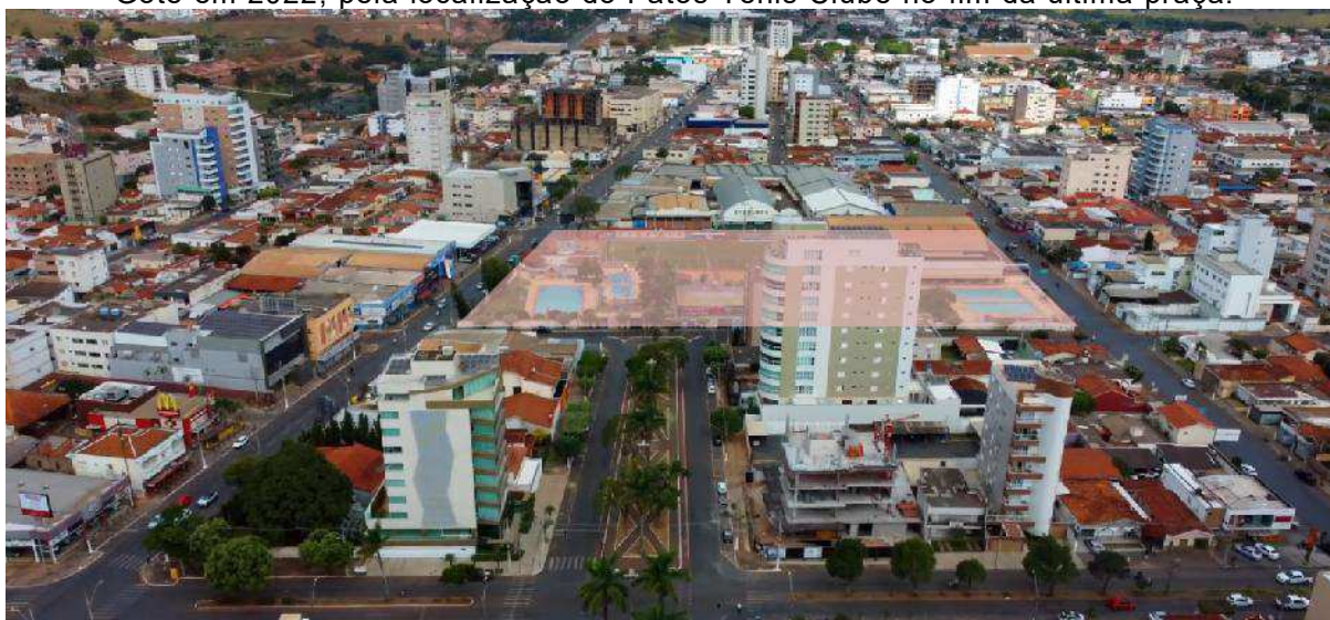
Figura 50 - Permanência da falta de ligação direta da Av. Getúlio Vargas e da R. Major Gote em 2022, pela localização do Patos Tênis Clube no fim da última praça.
