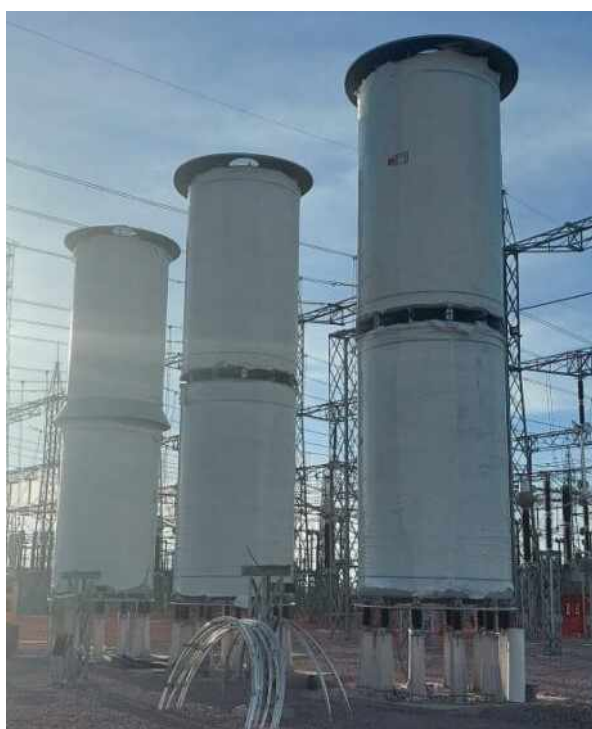
Figura 2 – Reatores de Núcleo de ar em uma subestação de energia (ELETRÔNICA, 2024)
