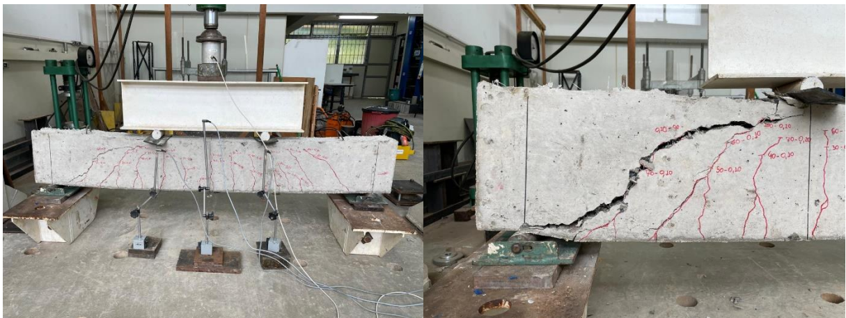
Figura 71: Viga V22-GS após ensaio. Ruptura por força cortante.
