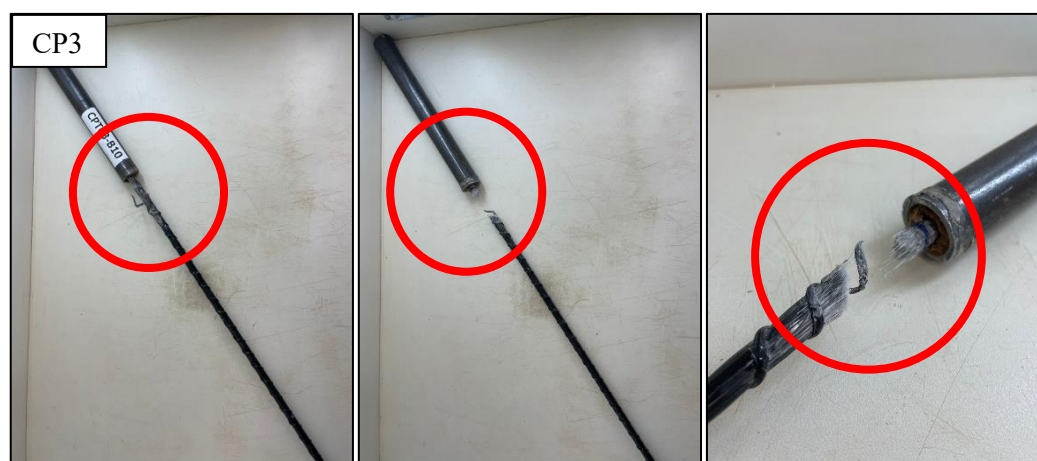
Figura 63: CP3 - Ruptura do GFRP na nervura, próximo à ancoragem inferior e ruptura total próximo a ancoragem superior.
