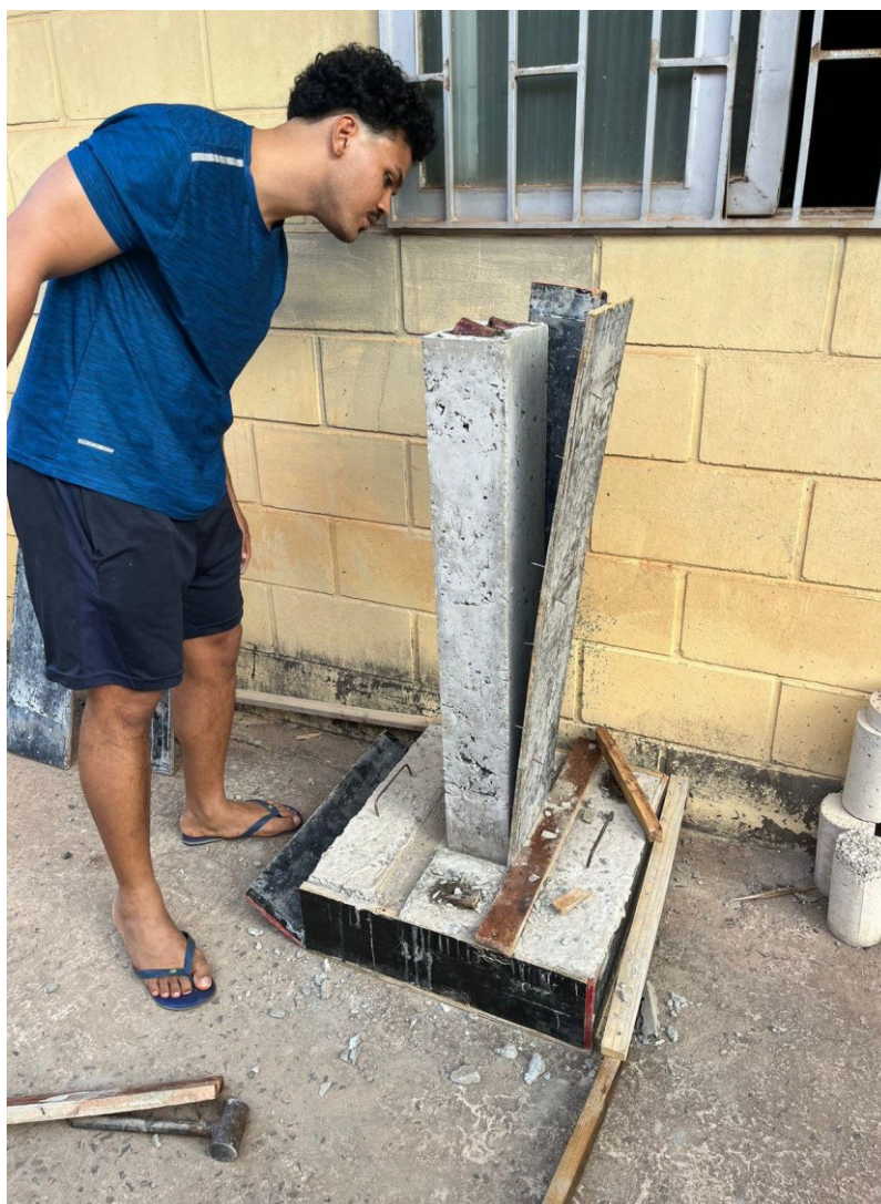
Figura 47 - Processo de desenformar o pilar. 2024.
