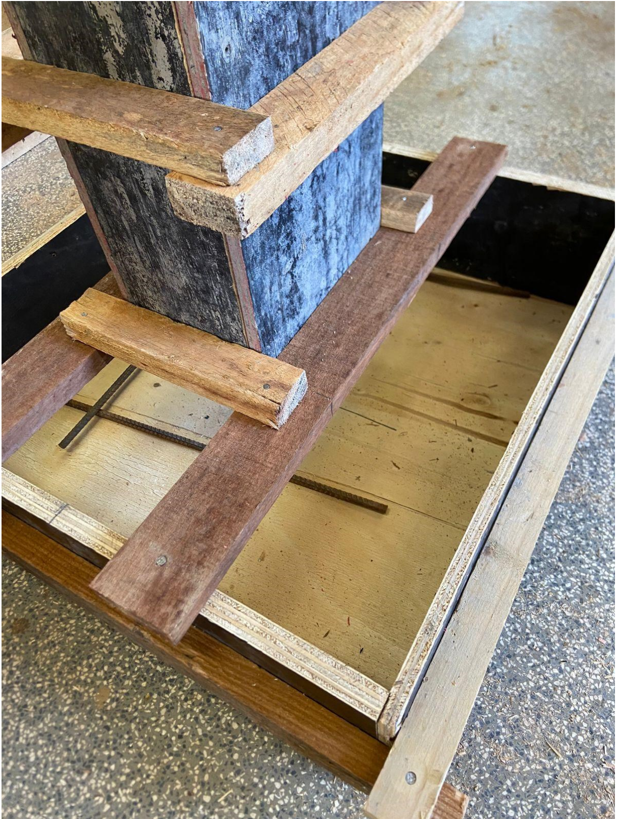
Figura 37 - Recorte da elevação do pilar sobre a sapata. 2024.
