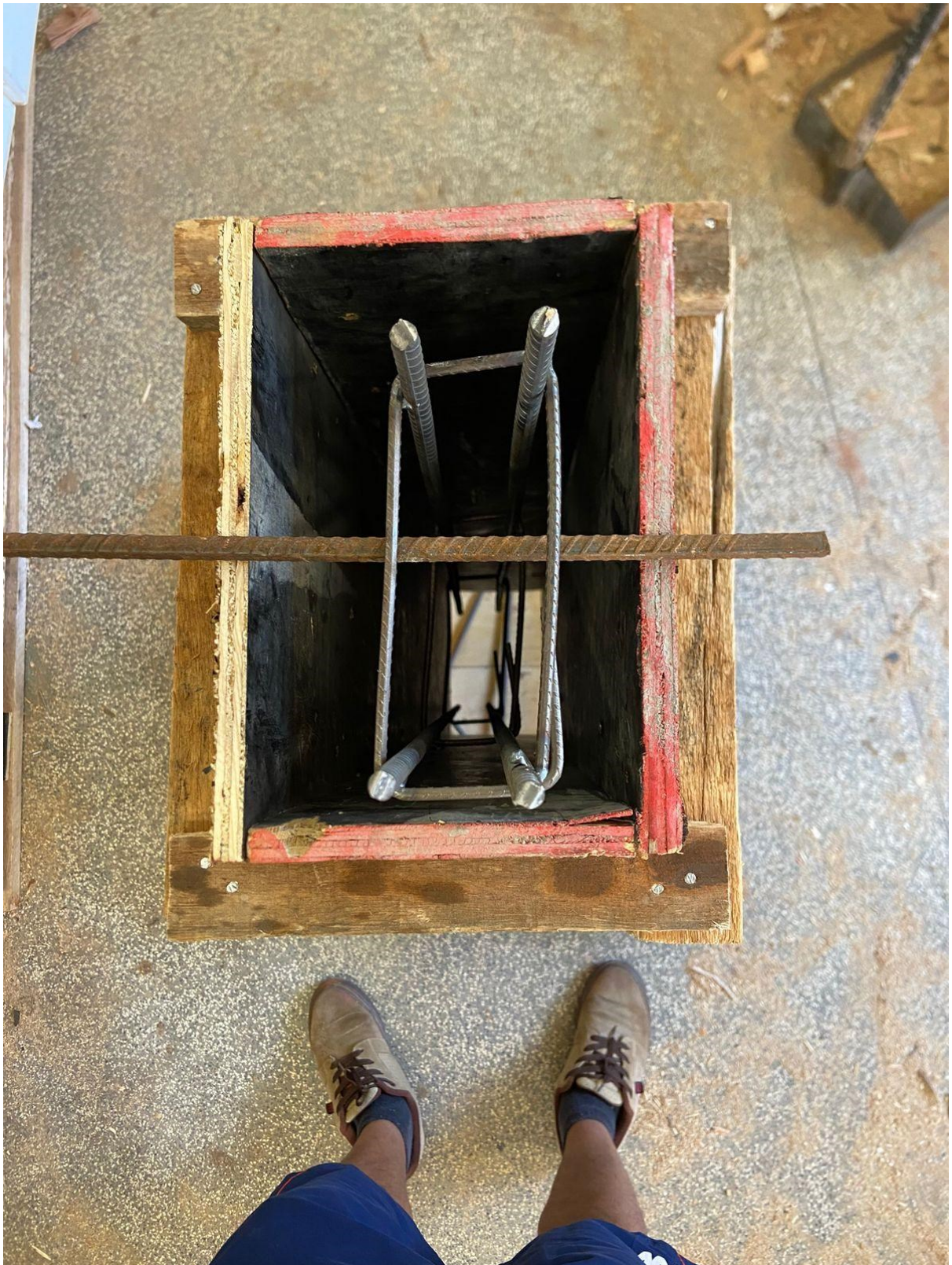
Figura 39 - Visão de cima da fôrma do pilar e sapata. 2024.
