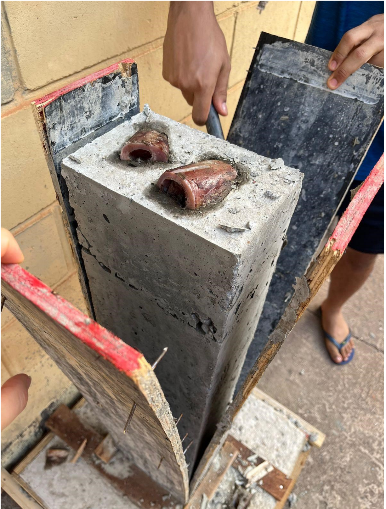
Figura 48 - Processo de desenformar o pilar. 2024.
