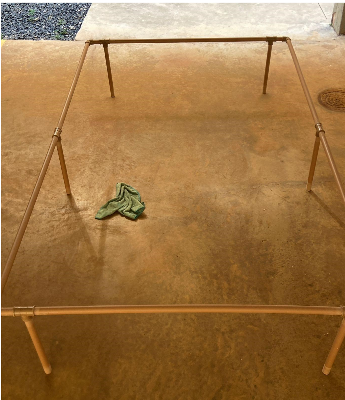
Figura 52 - LOURENÇO, Luan. Estrutura da piscina . 2024. Tubo pvc \frac{3}{4} . 200x100x35 cm.
