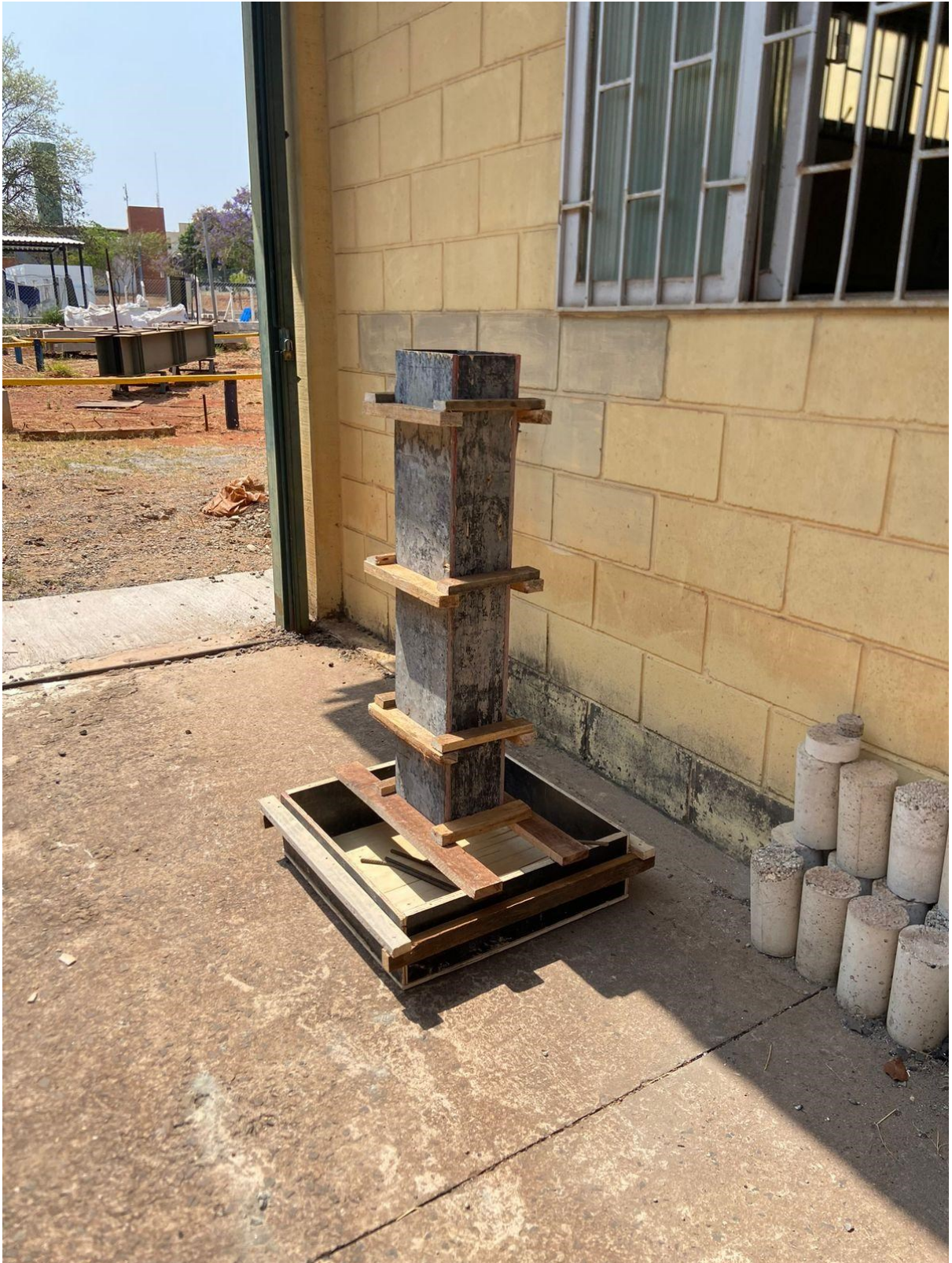
Figura 40 - Estrutura da forma pronta. 2024.
