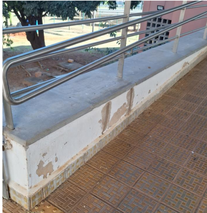
Figura 13: Rampa de acesso ao bloco 5R-A
