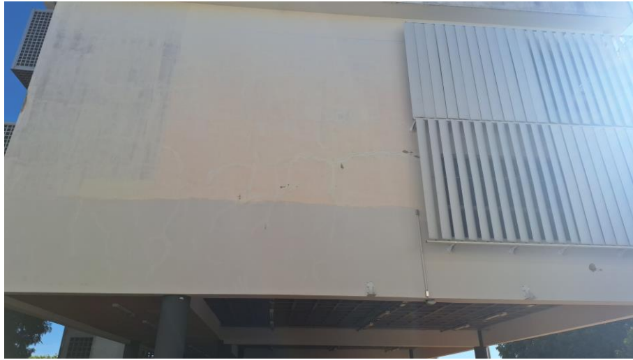
Figura 23: Fachada frontal do bloco 50
