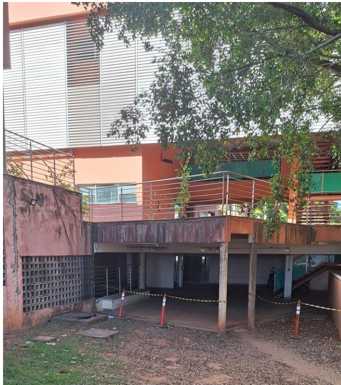
Figura 10: Fachada Traseira do bloco 5R-A
