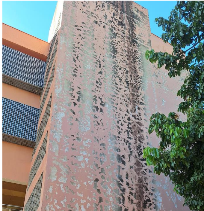
Figura 11: Fachada Lateral do bloco 5R-B
