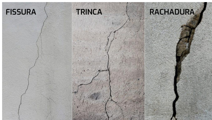
Figura 5: Diferença entre fissura, trinca e rachadura
