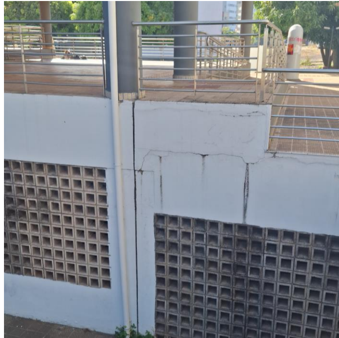
Figura 25: Fachada Lateral do bloco 50-B
