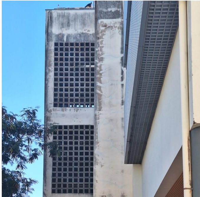
Figura 24: Fachada Lateral do bloco 50
