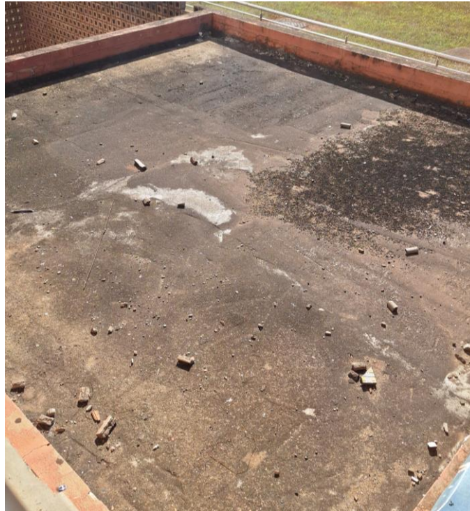
Figura 14: Cobertura no bloco 5R-A
