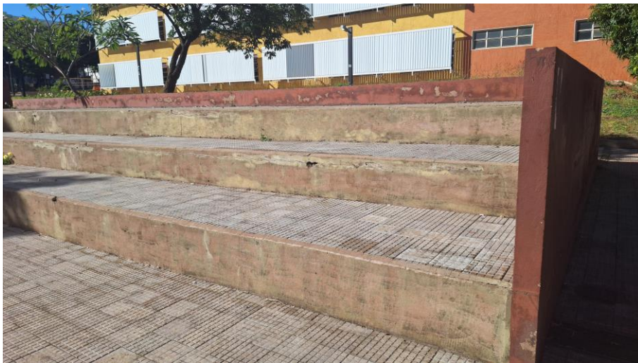
Figura 22: Escada de acesso ao bloco 50
