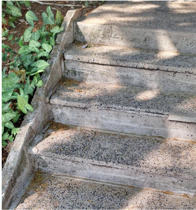
Figura 9 Escada de acesso ao bloco 1X
