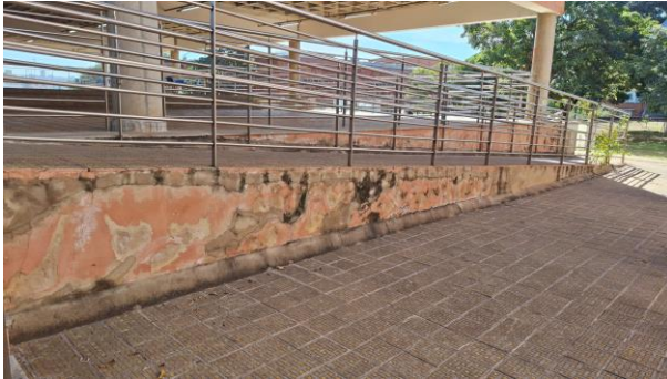
Figura 16: Rampa de acesso ao bloco 5R-A
