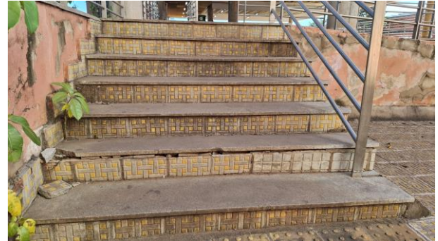
Figura 17: Escada de acesso ao bloco 5R-A
