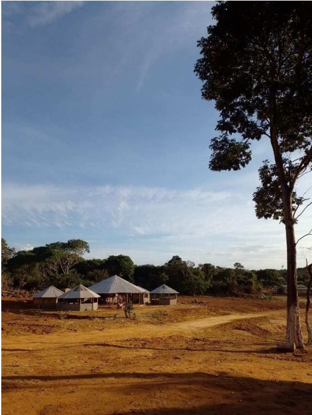
Figura 5 - Centro cultural em construção.
