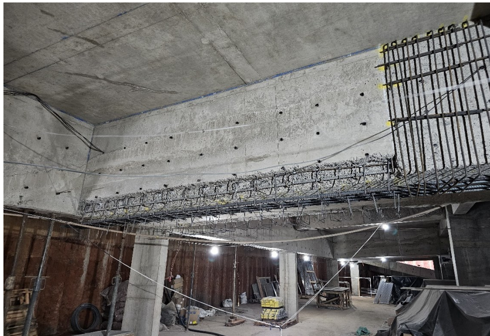
c) Viga de transição escarificada e com armadura parcialmente montada
