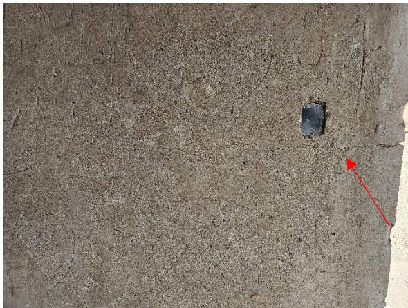
Figura 6 – Fissuras em reboco do 1º e 2º pavimentos
