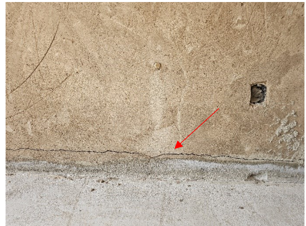
Figura 6 – Fissuras em reboco do 1º e 2º pavimentos
