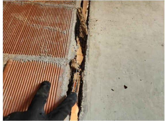
Figura 5 – Fissuras em alvenarias do 1º e 2º pavimentos
