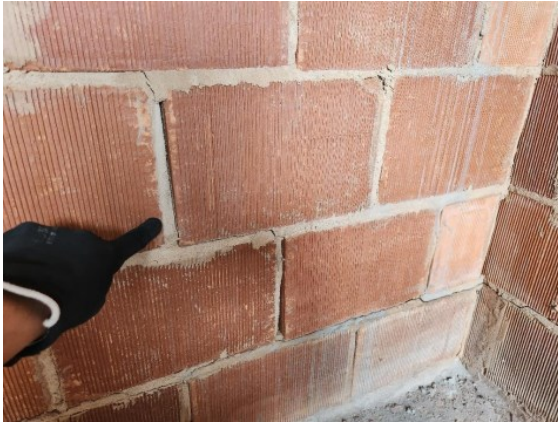
Figura 5 – Fissuras em alvenarias do 1º e 2º pavimentos
