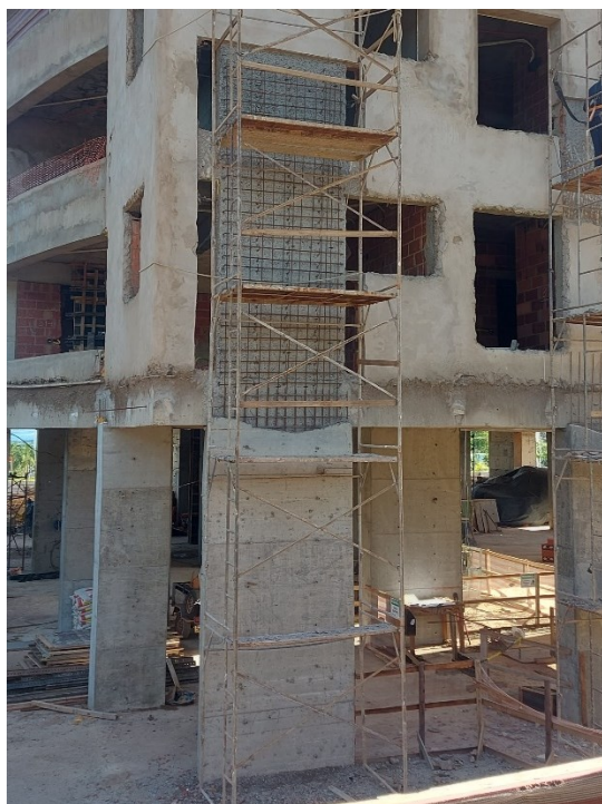
c) Viga de transição escarificada e com armadura parcialmente montada
