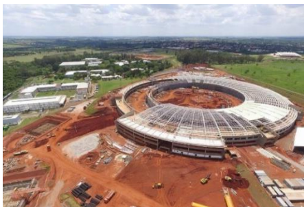
Figura 7 - Fase de Construção do Sirius
