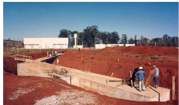
Figura 3 Construção do LINAC
