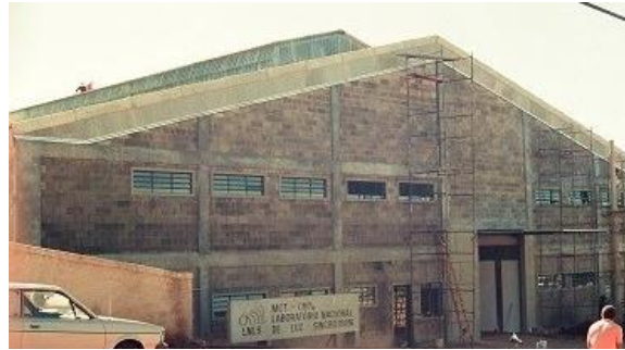
Figura 2 Barracão Industrial do LNLS, 1987
