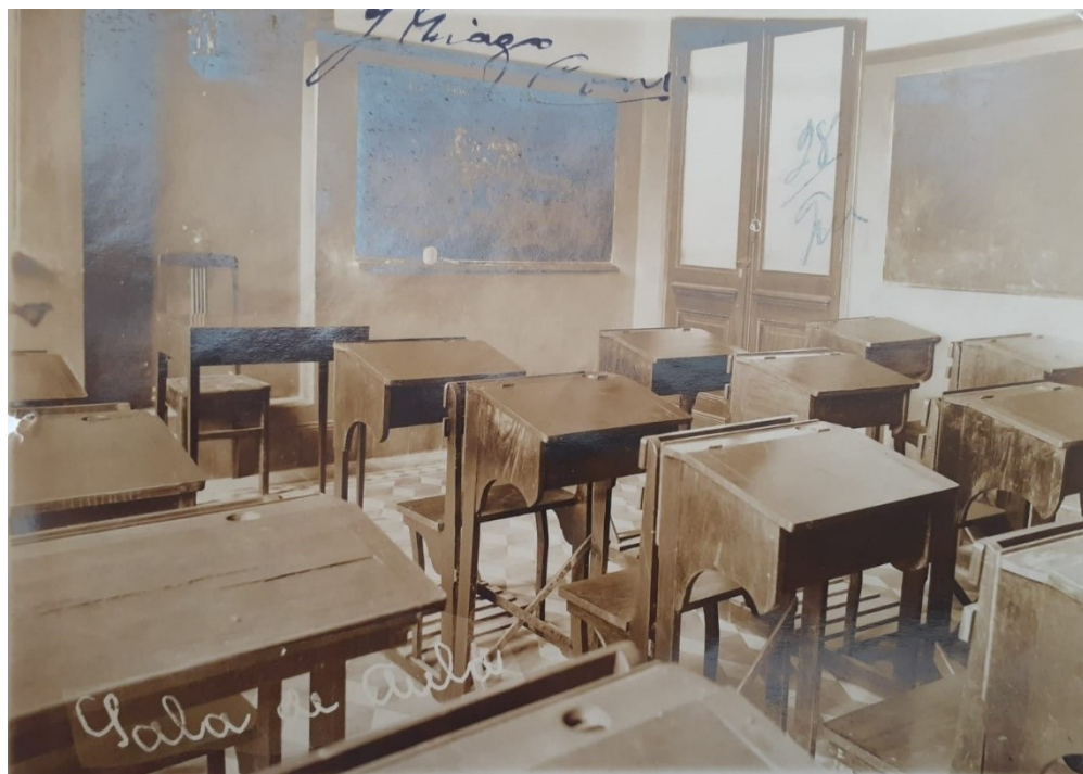
Figura 60 - Sala de aula Colégio Nossa Senhora das Dores. S.d.
