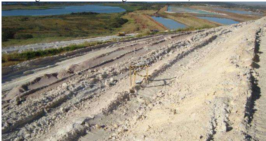
Figura 2.8 - Pilha de fosfogesso em Uberaba, Minas Gerais.
