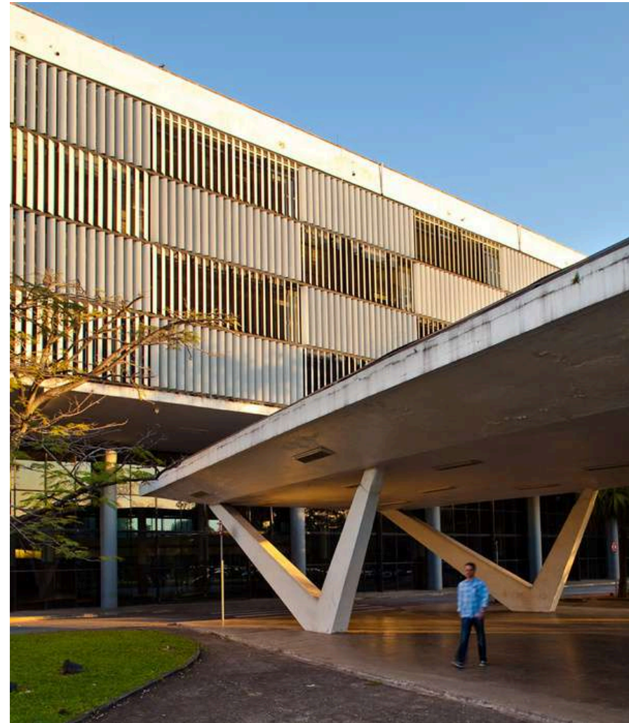
Fig. 54: Pavilhão Ciccillo Matarazzo | Pedro Kok Fonte: Archdaily
