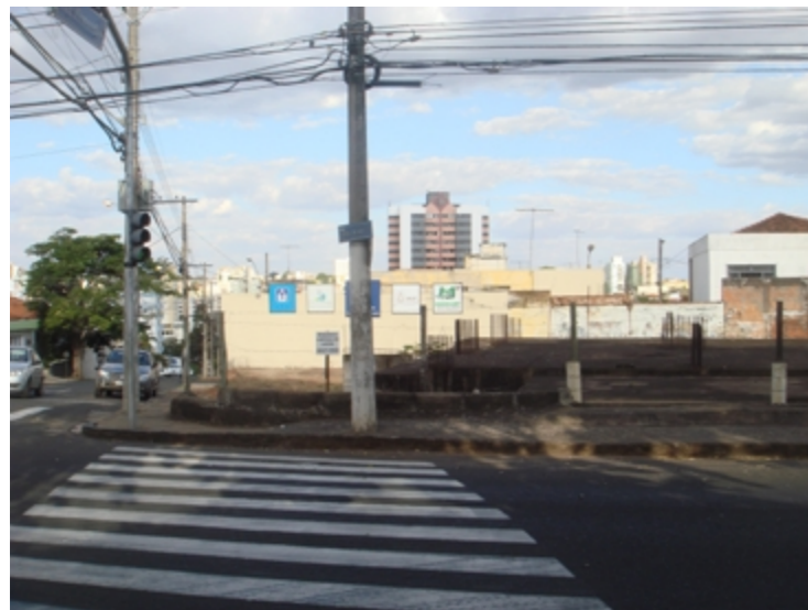
Figura 64. Ruína. Fonte: Guilherme Vendramini, 2013.
