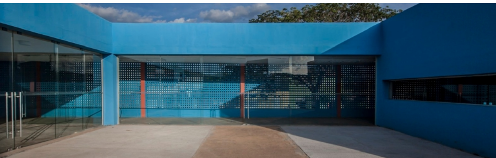
Figura 43. Acesso central do museu. Fonte: Junia Mortimer, 2012.
