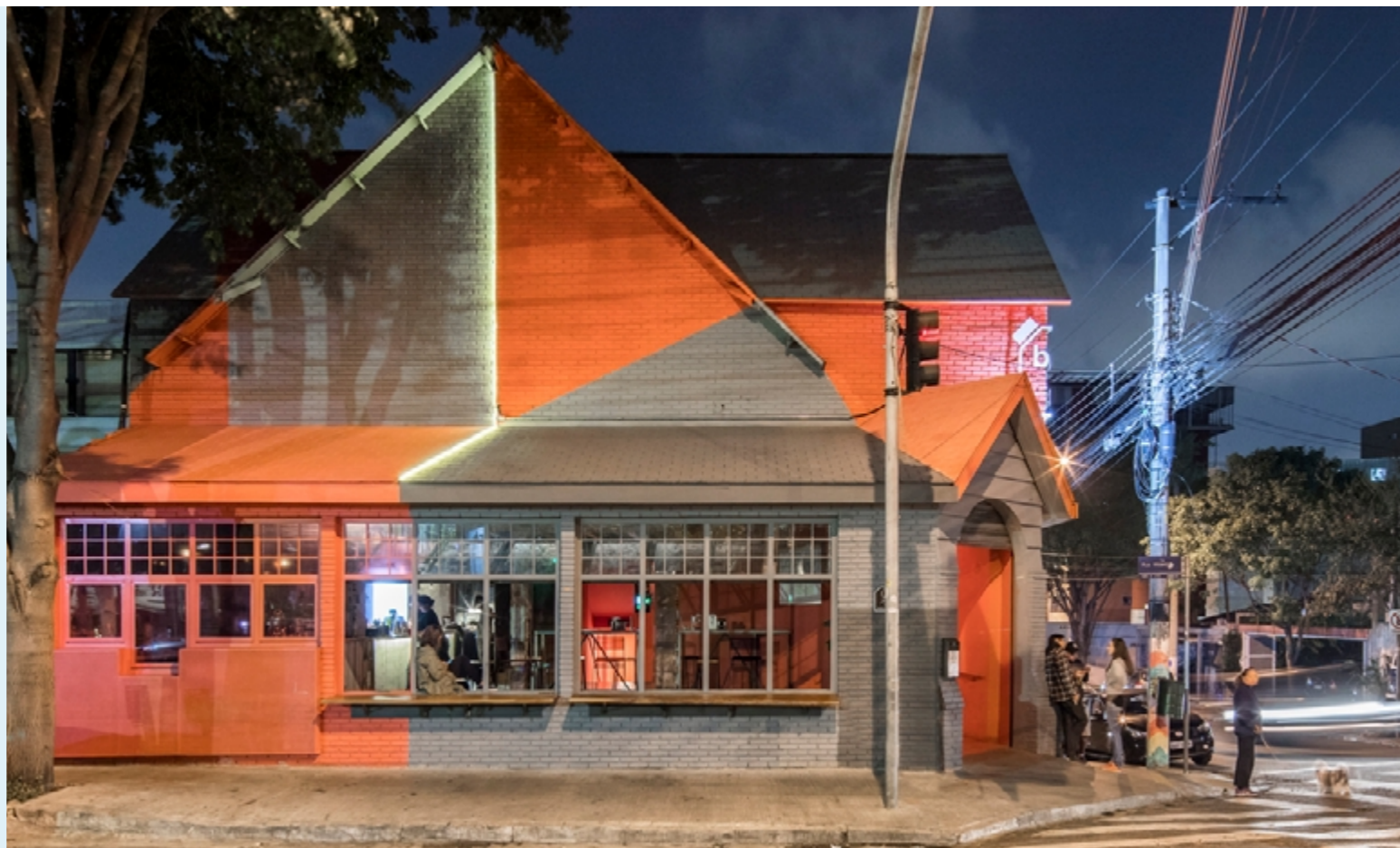
Figura 48. Fachada benzina. Fonte: Mayara Acayaba, 2017.
