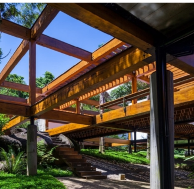
Figura 26: Grelha Estrutural. Fonte: Alexandre Schneider 2007.
