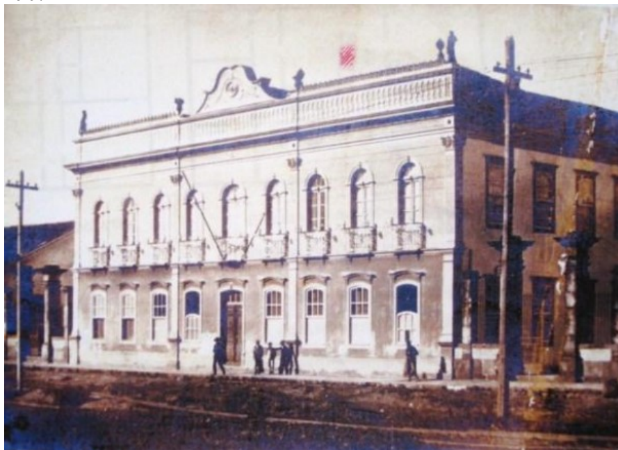
FIGURA 23. Fachada dos Grupos Escolares Centrais de Juiz de Fora - 1907
