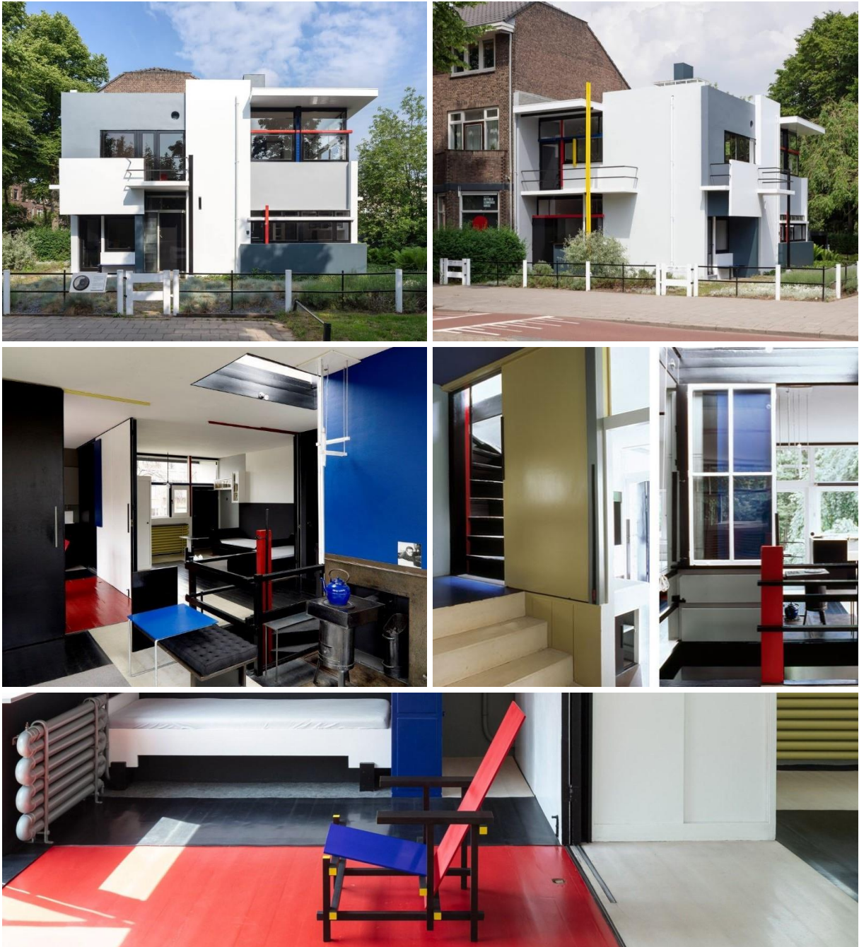
Figura 18, 19, 20, 21 e 22. Casa Schröder – Gerrit Rietveld Fonte: Archtrends Portobello e Design Best Magazine
