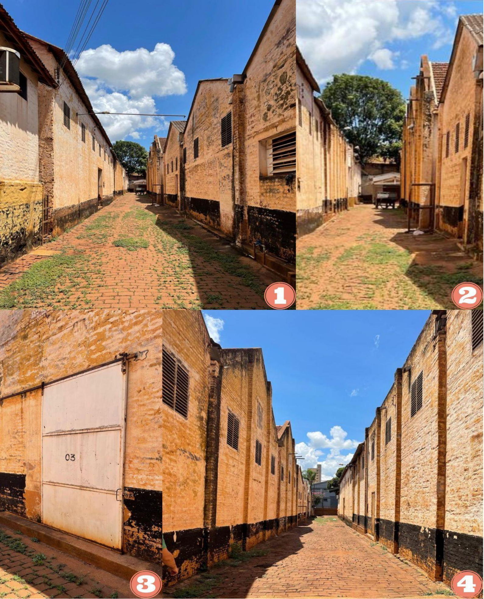
Figura 59: conjunto de imagens da rua interna. Em ordem: vista da entrada do complexo (1), vista do fundo da rua interna (2), uma das tipologias de portas dos armazéns (3), vista do interior da rua para a cidade (4). Fonte: autora, 2021.
