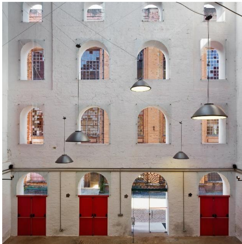
Figura 47: vista por dentro da fachada (foyer). Fotos: Nelson Kon. Disponível em: < http://brasilarquitectura.com/# >. Acesso em: dezembro de 2022.
