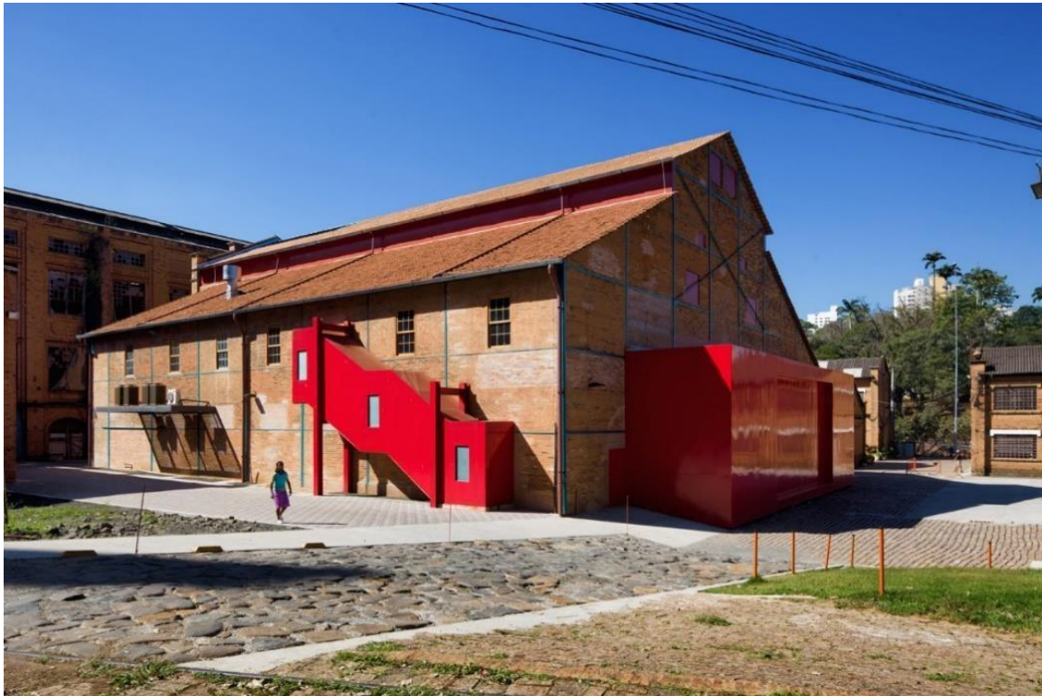
Figura 53: extensões em estrutura metálica pintadas de vermelho (escada de acesso aos camarins e ampliação do palco). Fotos: Nelson Kon. Disponível em: < http://brasilarquitetura.com/# >. Acesso em: dezembro de 2022.
