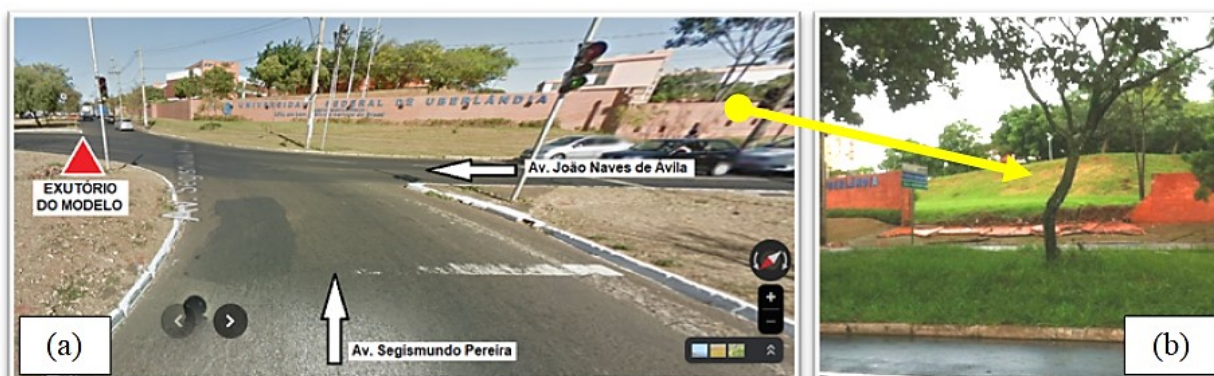
Figura 70 (a) – Cruzamento viário da Avenida João Naves de Ávila com Avenida Segismundo Pereira; (b) – Desabamento de parte do muro do Campus Santa Mônica no ano de 2013.
