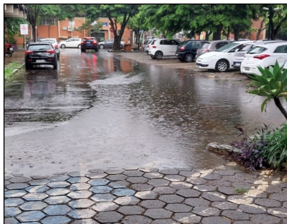
Figura 65 – Trecho n.º 17 – 20. Ocorrência de alagamento pós-precipitação de 6,8 mm em uma hora. Visão a partir do ponto n.º 17
