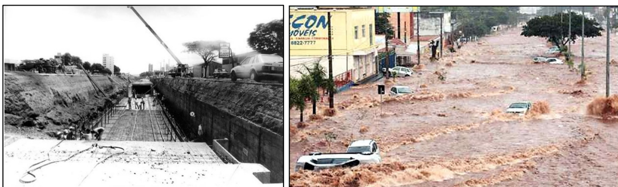
Figura 23 (a) – Obra de expansão da galeria de águas pluviais do Córrego São Pedro (1992); (b) – Inundação na Avenida Rondon Pacheco registrada em 30/05/2013.
