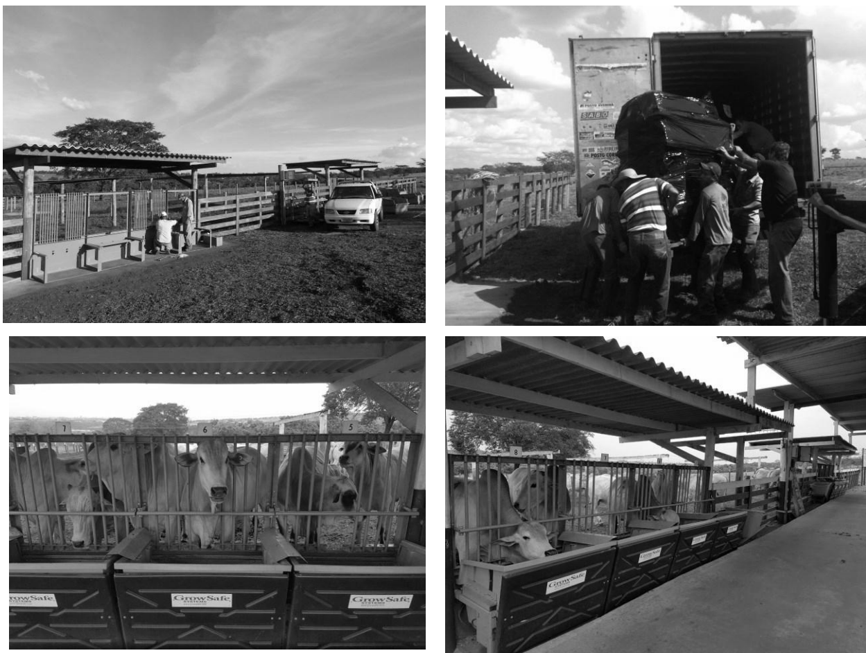
Figura 4. Instalação do Sistema Eletrônico Growsafe®.
