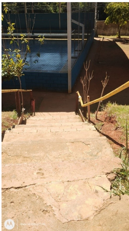
Figura 11 - Escada de acesso à quadra esportiva
