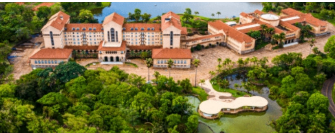
Figura 08 Foto do Complexo Termal - Grande Hotel de Araxá. Fonte: Grande Hotel Araxá. Disponível aqui .
