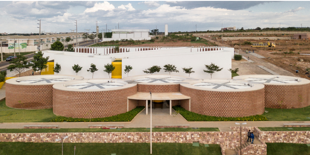
Figura 37 Foto da edificação. Fonte: Archdaily. Disponível aqui .
