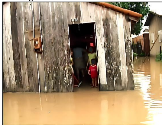
Figura 26: Casa alagada às margens do Riacho Bacuri - 2008
