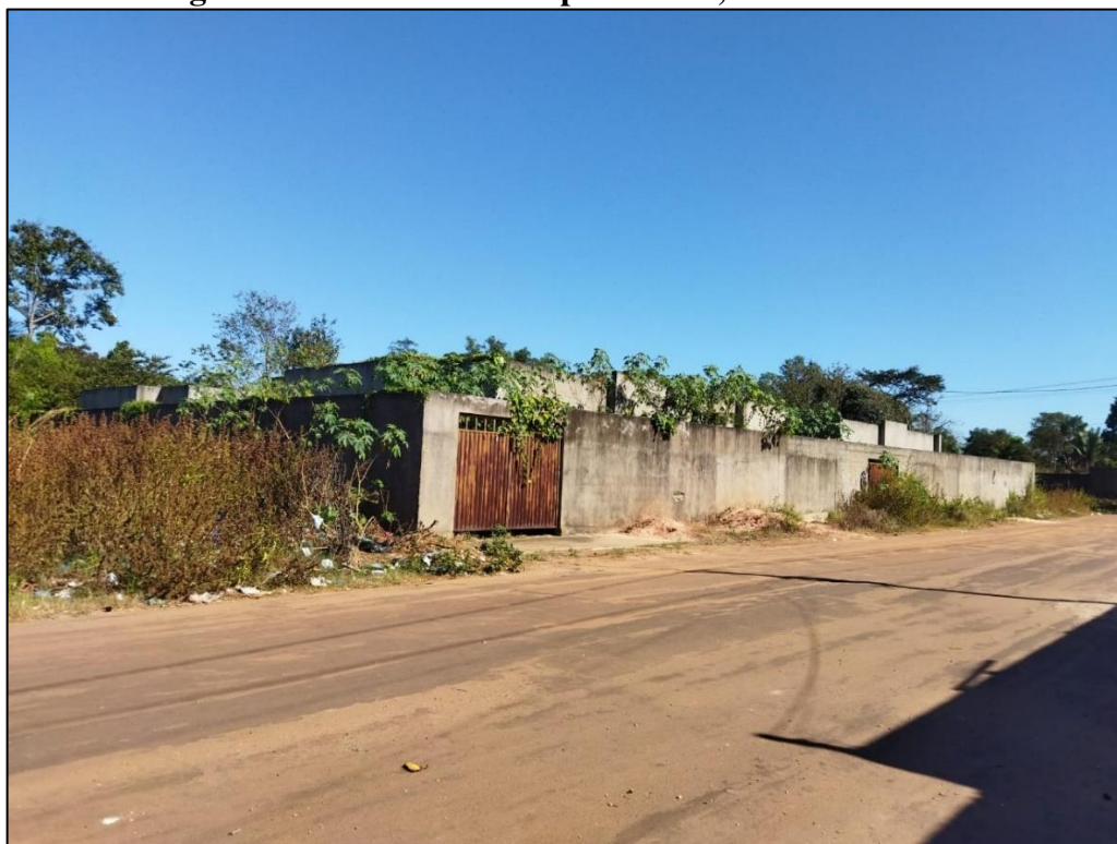
Figura 31: Obra de creche paralisada, Itamar Guará – 2024
