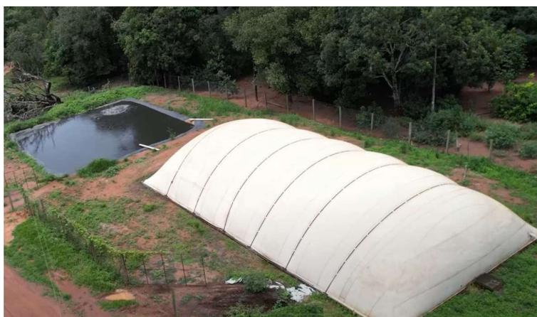
Figura 2.4 – Biodigestor modelo Canadense (AUTOR, 2022).
