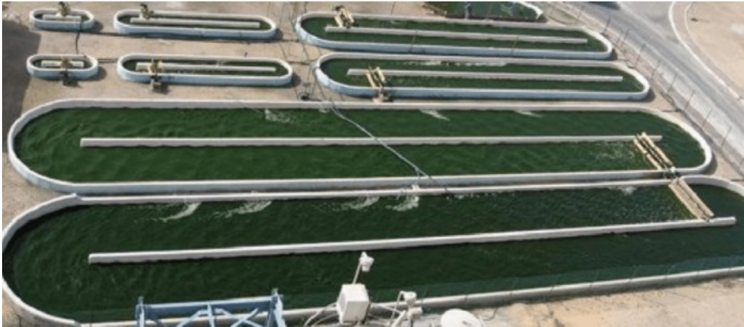
Figura 2 - Cultivo de microalgas em tanques raceway em Califórnia, EUA
