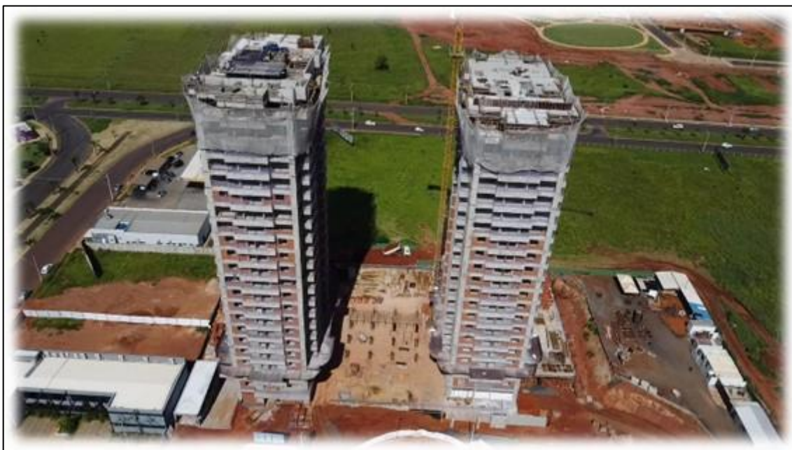
Figura 42 - Obra Chess em andamento, Brasal Incorporações, 2024
