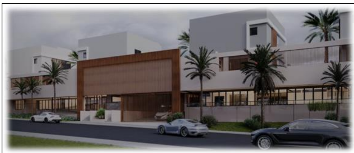
Figura 65 - Perspectiva da fachada do condomínio Dolce Vita , Persa, 2023
